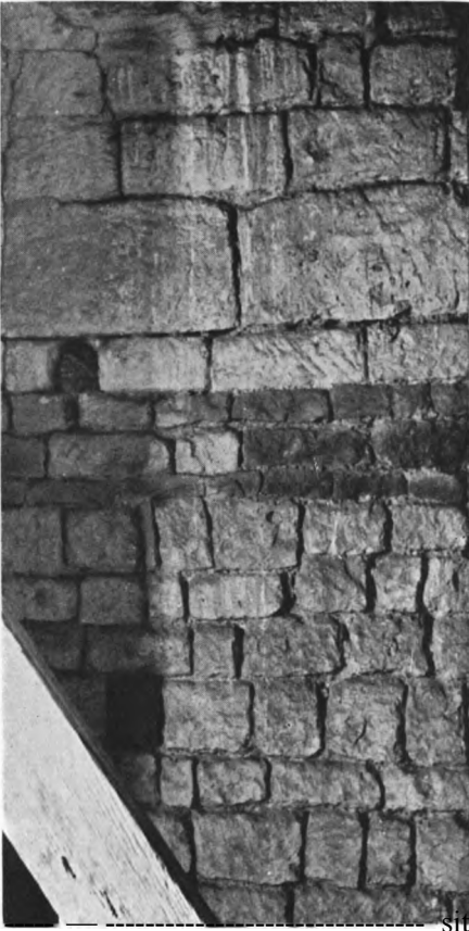
Fig. 3. Solrod. Murværksdetalii af Skibets Vestgavl, set fra Taarnet (S. 1083).
