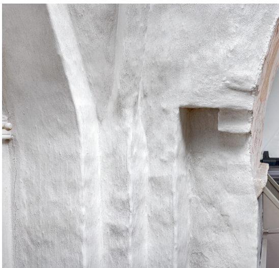
Fig. 10. Aftrapninger (s. 3327). Detalje af korbue. Foto Arnold Mikkelsen 2022. – Corbie steps. Detail of chancel arch.
