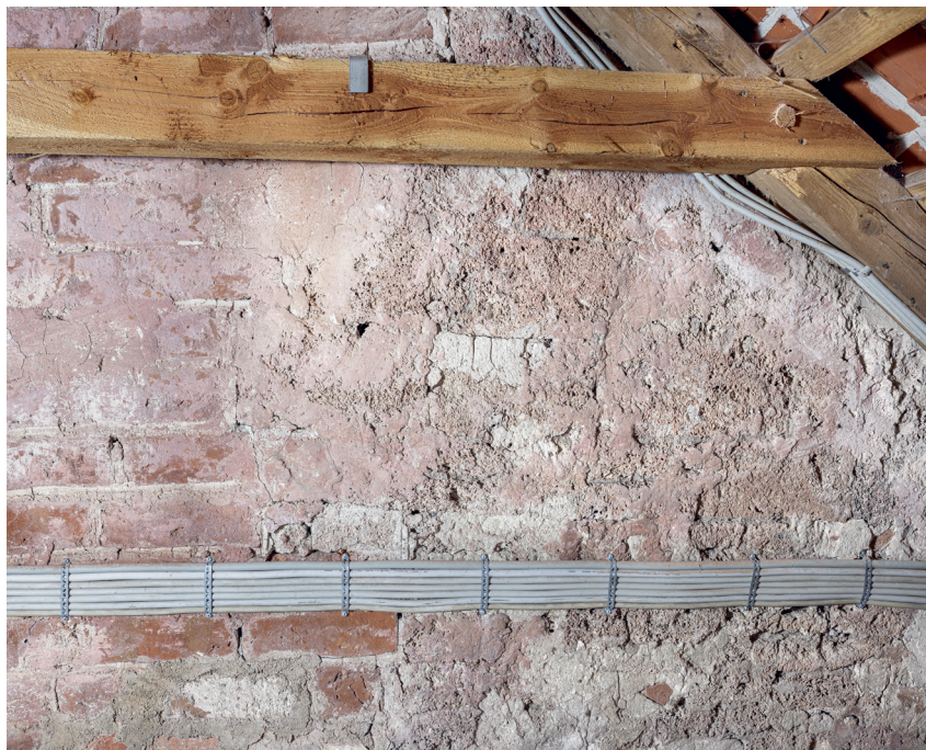
Fig. 58. Detalje af skibets sydside med munkesten og frådstenskvadre set fra våbenhusets loft. Foto Arnold Mikkelsen 2022. – Detail of the south side of the nave with large medieval bricks and tufa ashlar seen from the loft of the porch.
