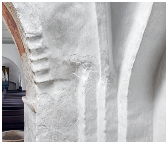
Fig. 11. Aftrapning (s. 3327). Detalje af korbue. Foto Arnold Mikkelsen 2022. – Corbie steps. Detail of chancel arch.
