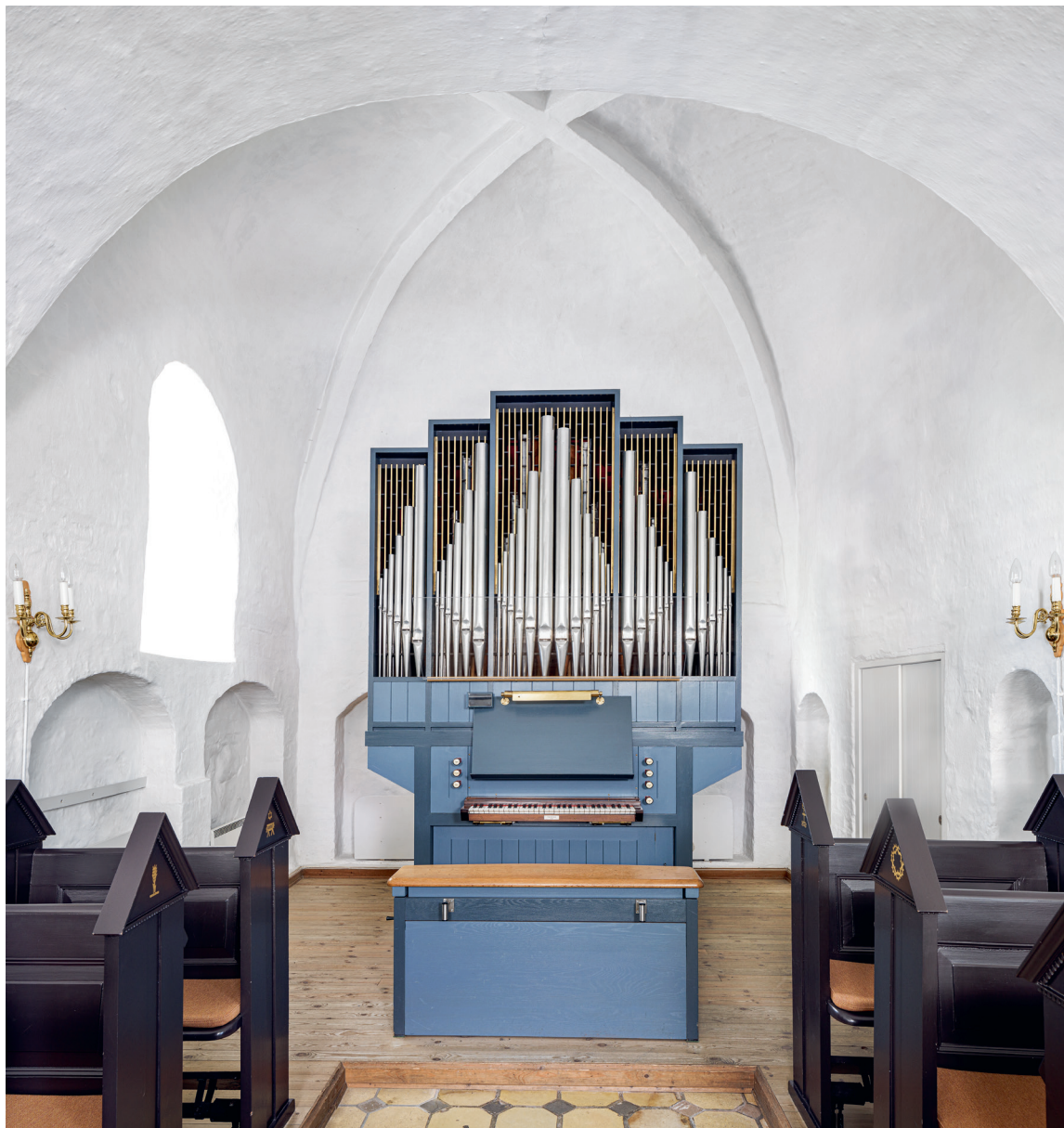
Fig. 49. Tårnrum med orgel (s. 3357) og nicher (s. 3329). Foto Arnold Mikkelsen 2022. – The inside of the tower with organ and niches.
