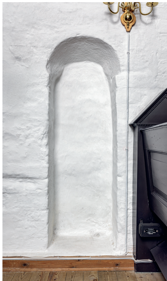
Fig. 57. Niche i tårnrum med genanvendt overligger (s. 3329). Foto Arnold Mikkelsen 2022. – Niche inside the tower with reused lintel.
