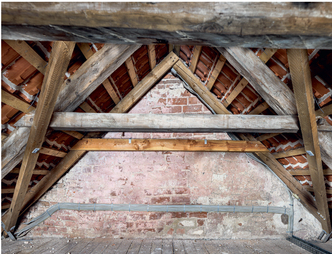
Fig. 14. Skibets sydside med munkesten og frådstenskvadre (s. 3327) set fra våbenhusets loft. Foto Arnold Mikkelsen 2022. – The south side of the nave with large medieval bricks and tufa ashlars seen from the loft of the porch.
