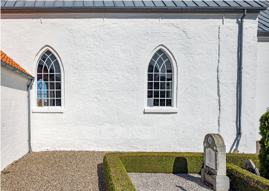
Fig. 9. Skibets sydside med \dagger vinduer og lisenrest (s. 3334 og 3325). Foto Arnold Mikkelsen 2021. – The south side of the nave with \dagger windows and remains of pilaster.
