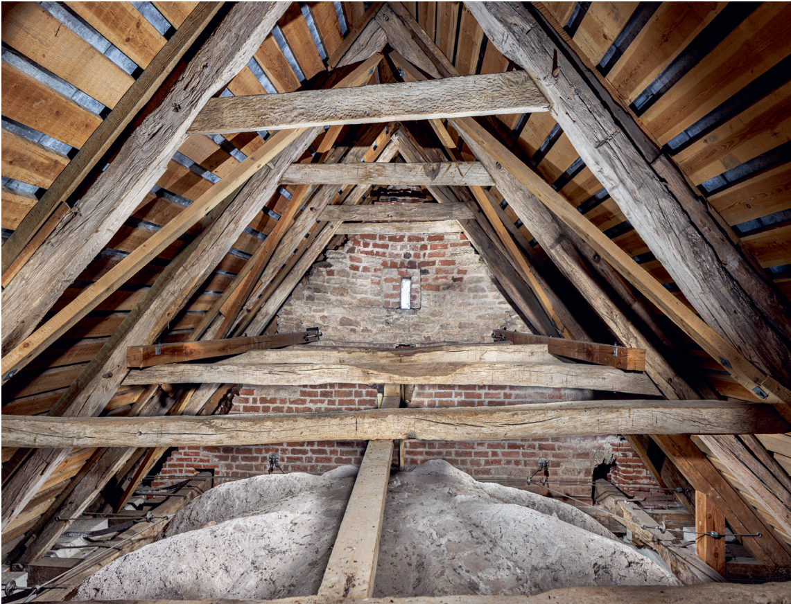
Fig. 15. Korets tagværk og dets østre gavltrekant med genanvendte frådsten (s. 3327). Foto Arnold Mikkelsen 2022. – The roof structure of the chancel and its eastern gable triangle with re-used tufa.
