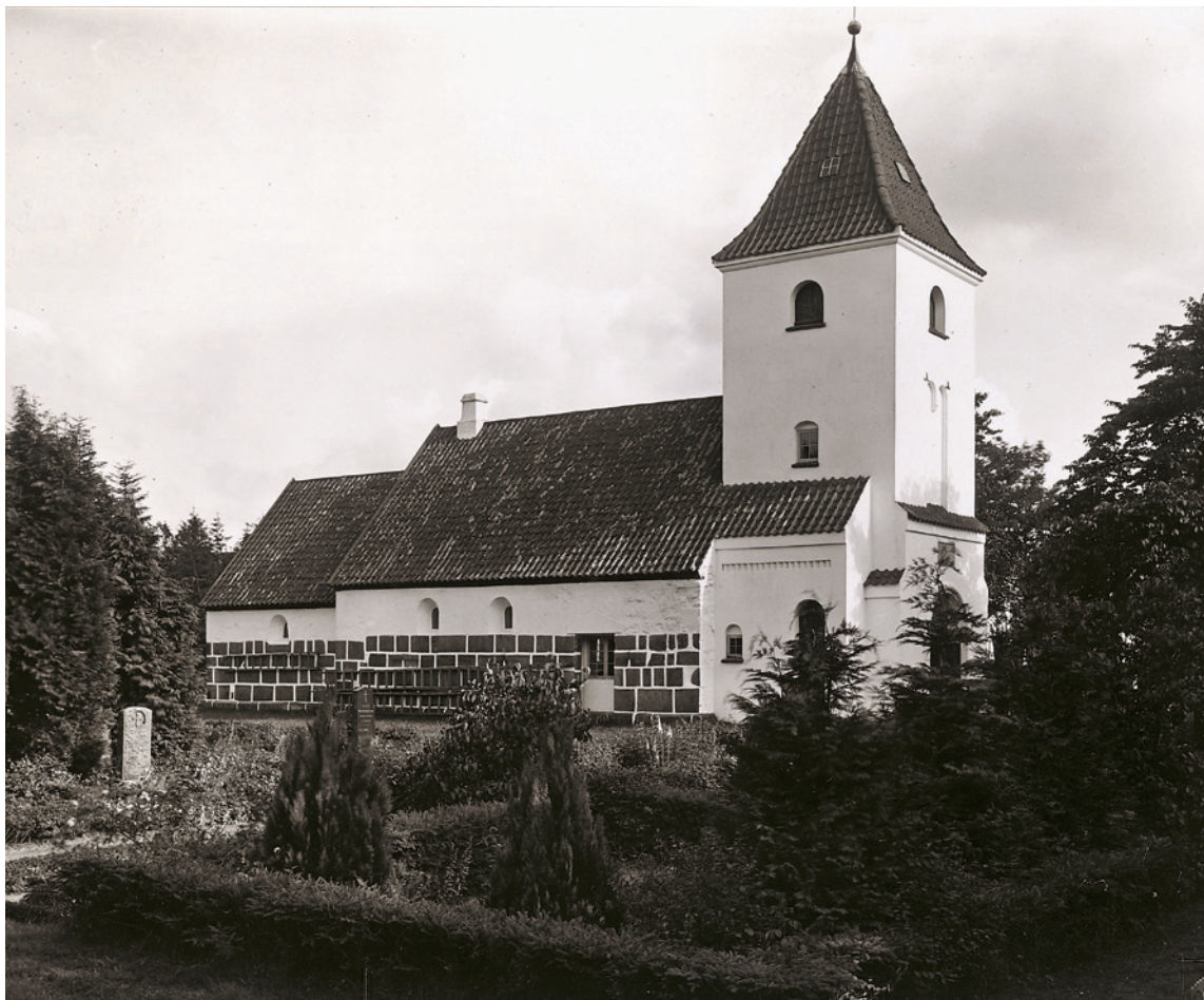
Fig. 13. Kirken set fra nordvest. Foto Hugo Matthiessen 1938. – The church seen from the north west.
