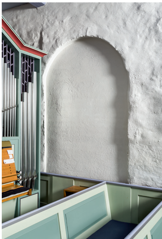
Fig. 30. Norddøren med buestik set indefra (s. 2536). Foto Arnold Mikkelsen 2017. – North door of nave with rounded arch seen from the inside.
