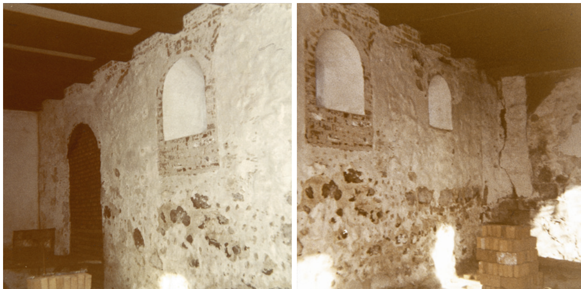
Fig. 28-29. Kirkens nordvæg efter afrensning af kalk. Foto Helge Andreassen 1971. – North wall of the church after the removal of limewash.
