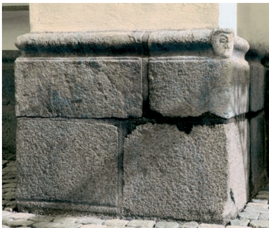
Fig. 8. Profilerede *sokkelkvadre, nu indsat i Trinitatis Kirke (s. 301 f. og 558 f.). Foto HW 2005. – Profiled *base ashlars, now incorporated in Trinitatis Church.
