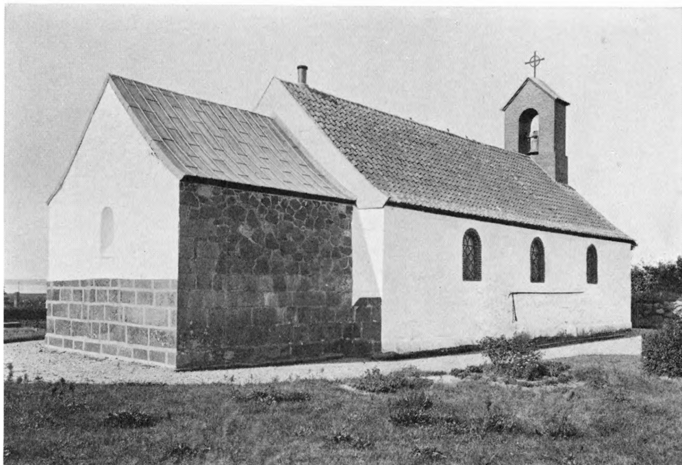
Fig. 4. Jegindø. Ydre, før Ombygningen 1919, set fra Nordøst.
