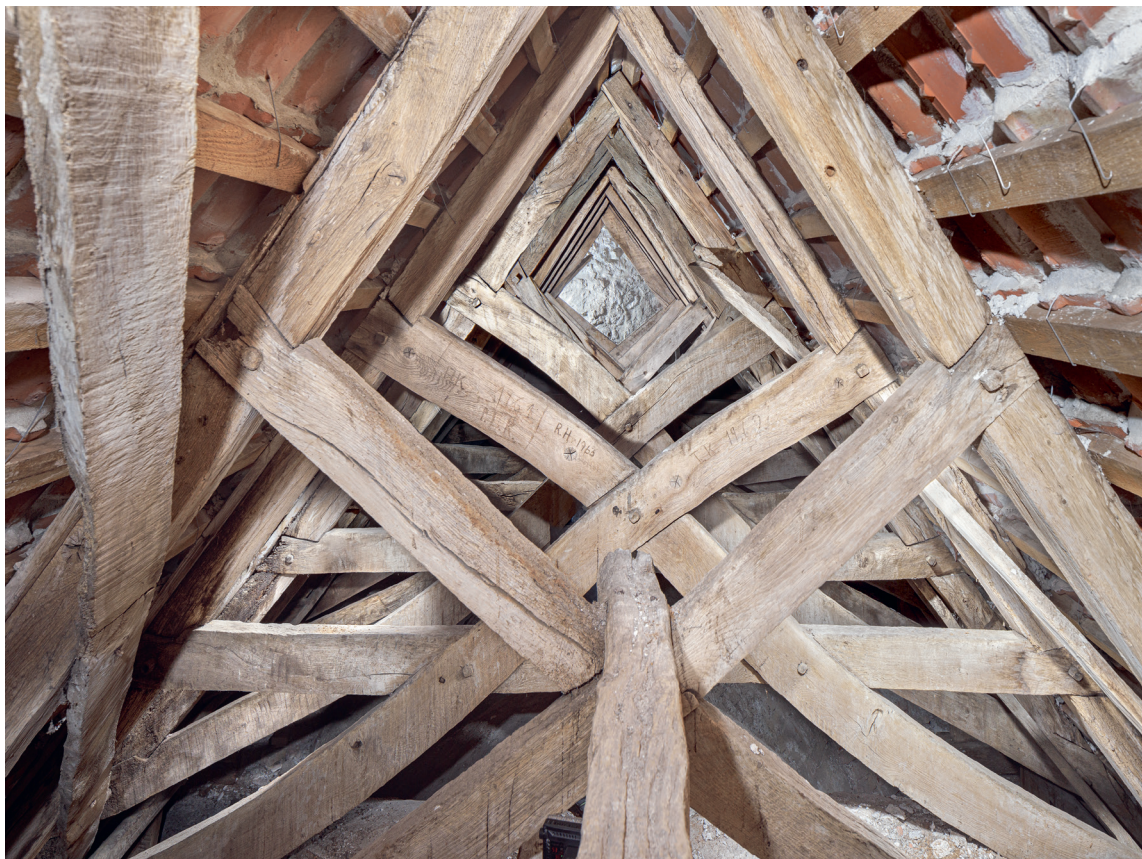
Fig. 27. Det forlængede kors senmiddelalderlige tagværk set mod vest (s. 3997). Foto Arnold Mikkelsen 2023. – The Late Medieval roofing of the extended chancel looking west.
