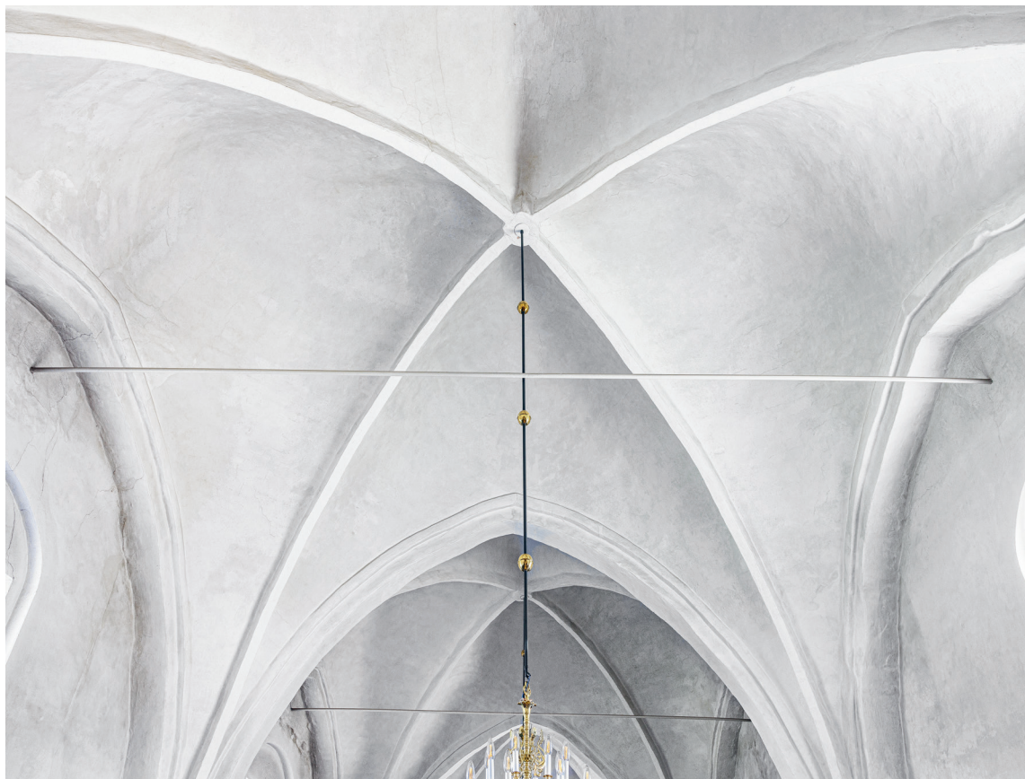
Fig. 17. Hvælvet i skibets vestligste fag set mod øst (s. 3986). Foto Arnold Mikkelsen 2023. – The vault in the westernmost bay of the nave looking east.
