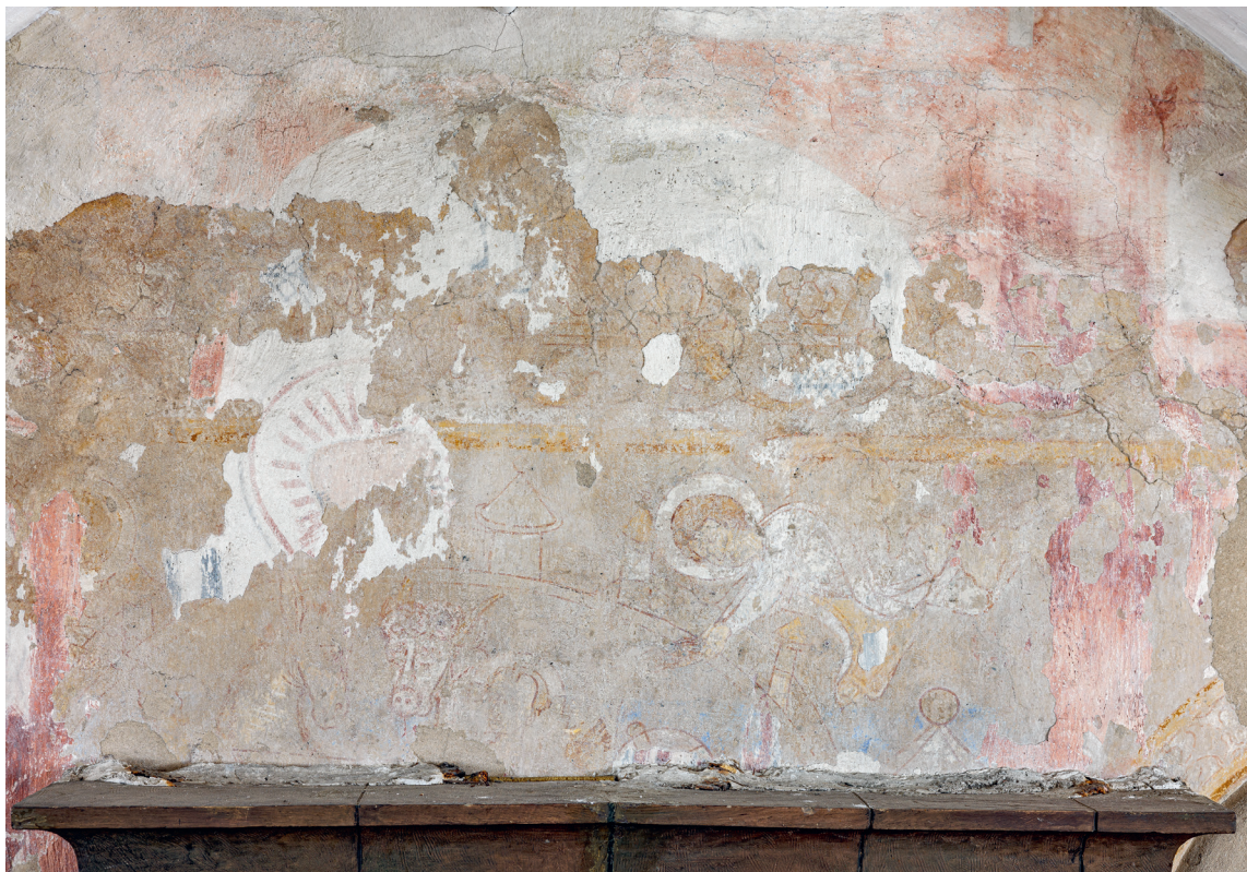
Fig. 33. Jesu fødsel. Detalje af senromansk kalkmaleri (nr. 1) på korets nordmur (s. 4002). Foto Arnold Mikkelsen 2023. – Nativity. Detail of Late Romanesque wall painting (no. 1) on the chancel's north wall.
