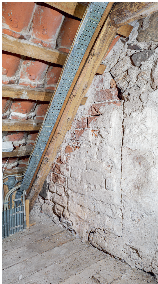
Fig. 15. Romansk \uparrow vindue med frådstensstik set fra våbenhusets loft (s. 3982). Foto Arnold Mikkelsen 2023. – Romanesque \uparrow window with travertine arch seen from the loft of the porch.
