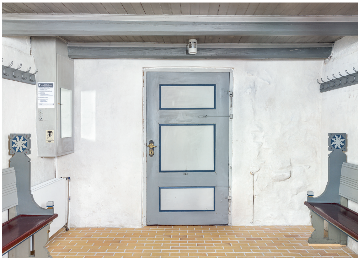
Fig. 21. Våbenhusets indre set mod nord (s. 3986). Foto Arnold Mikkelsen 2023. – Porch interior looking north.
