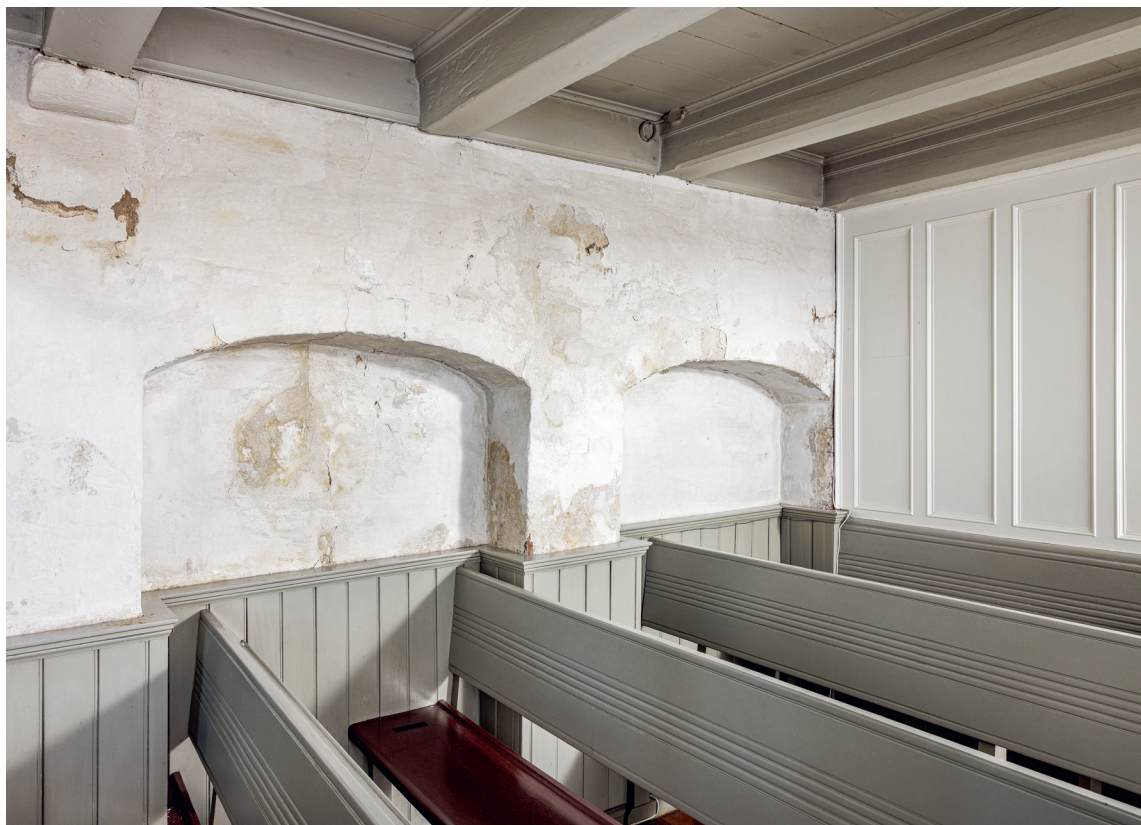
Fig. 23. Spareblændinger i tårnrummets sydvæg (s. 3988). Foto Arnold Mikkelsen 2023. – Material-saving recesses in the south wall of the tower interior.
