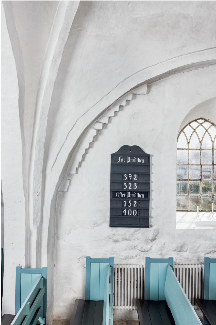
Fig. 16. Fortanding til ikke realiseret hvælv i vestforlængelsen (s. 3925) samt salmennummertavle, o. 1900 (s. 3956). Foto Arnold Mikkelsen 2023. – Toothing for an unrealized vault in the western extension and hymn board, c. 1900.
