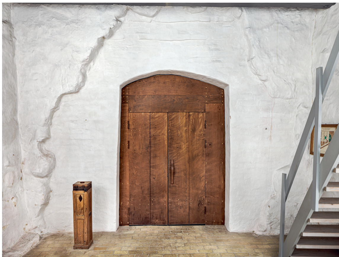
Fig. 21. Tårnrumssets indre set mod øst med pengeblok fra 1870 og dørfløj udført 1962 af genanvendt egetræ (s. 3926, 3955 og 3956). Foto Arnold Mikkelsen 2023. – Tower interior looking east with money box, 1870, and door wing, 1962, made from reused oak.
