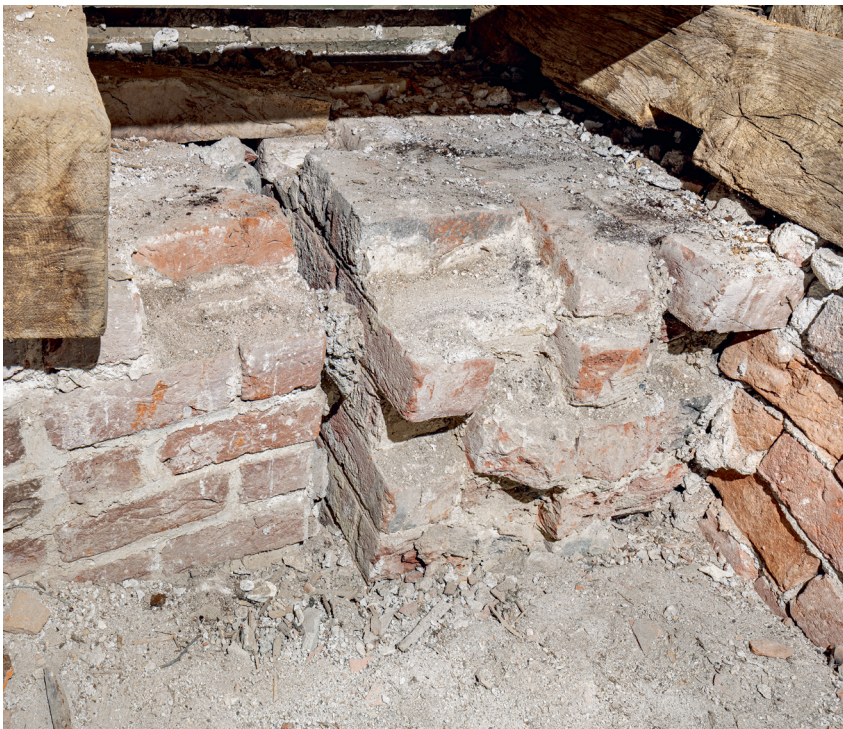
Fig. 19. Sammenstødet mellem skibet og vestforlængelsen set fra loftet (s. 3923). Foto Arnold Mikkelsen 2023. – The meeting of the nave and the western extension seen from the loft.
