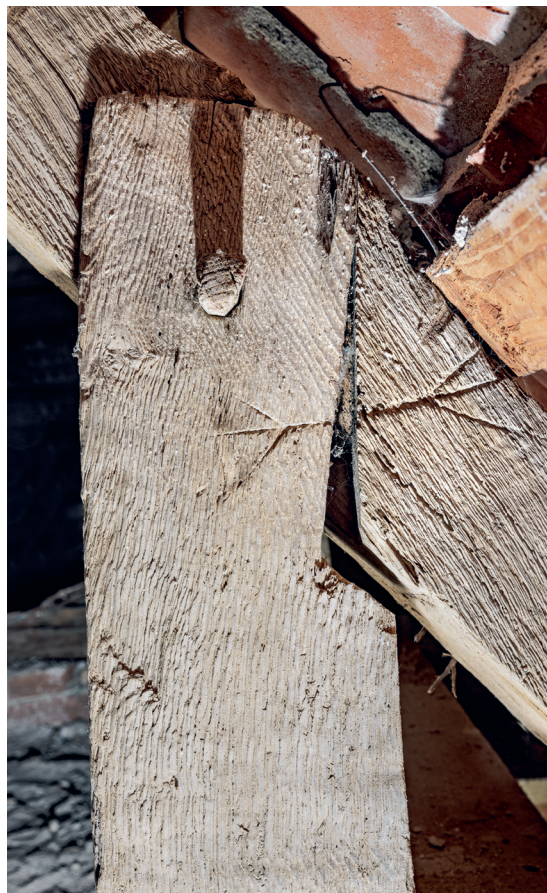
Fig. 70. Tommersamling og -mærke i sydsiden af vestforlængelsens tagværk (s. 3939). Foto Arnold Mikelsen 2023. – Timber joint and carpenter's mark in the south side of the roofing of the western extension.
