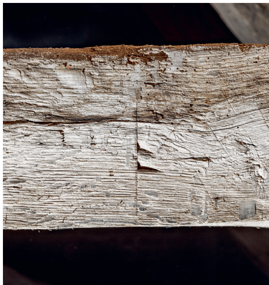
Fig. 69. Tømmermærke på 2. hanebånd fra vest i skibets nordside (s. 3938). Foto Arnold Mikkelsen 2023. – Carpenter's mark on the 2nd tie beam from the west in the north side of the nave.
