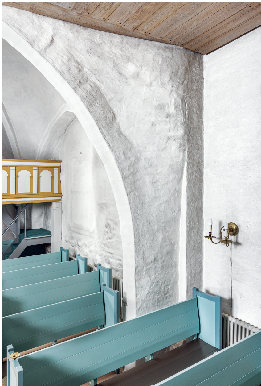
Fig. 15. Vange til †murblanding i skibets vestmur (s. 3922) samt krumt murværk til ikke realiserede hvælv i skibet (s. 3928). Foto Arnold Mikkelsen 2023. – Side member of the †wall recess in the western wall of the nave and curved masonry for unrealized vaults in the nave.
