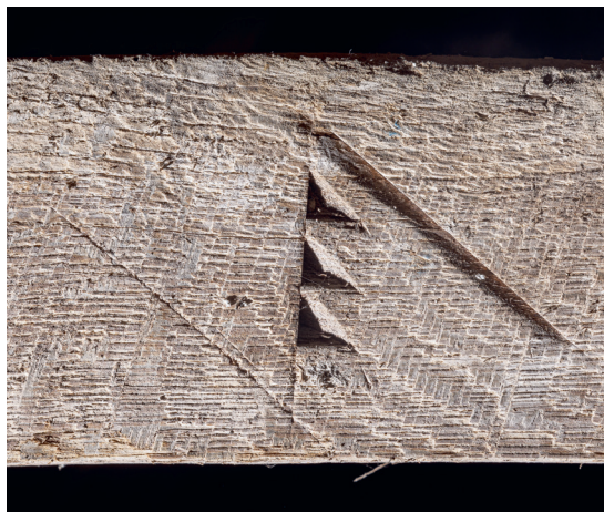
Fig. 31. Tømmermærke på 6. hanebånd fra vest i skibets sydside (s. 3938). Foto Arnold Mikkelsen 2023. – Carpenter's mark on the 6th tie beam from the west in the south side of the nave.
