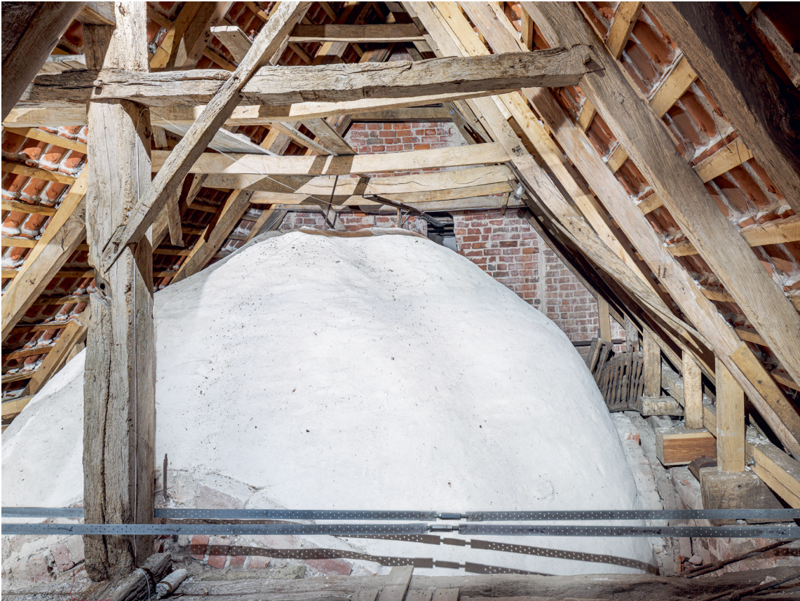
Fig. 32. Vestforlængelsens senmiddelalderlige tagværk og hvælv set mod vest (s. 3939). Foto Arnold Mikkelsen 2023. – The Late Medieval roofing of the western extension and vault looking west.
