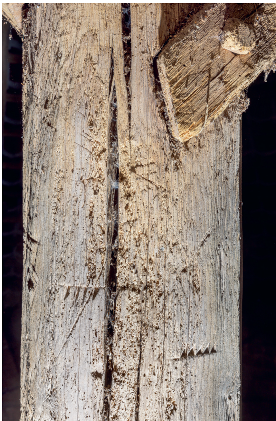
Fig. 30. Tømmermærker på koret's kongestolpe set mod øst (s. 3938). Foto Arnold Mikkelsen 2023. – Carpenter's marks on the kingpost of the chancel looking east.
