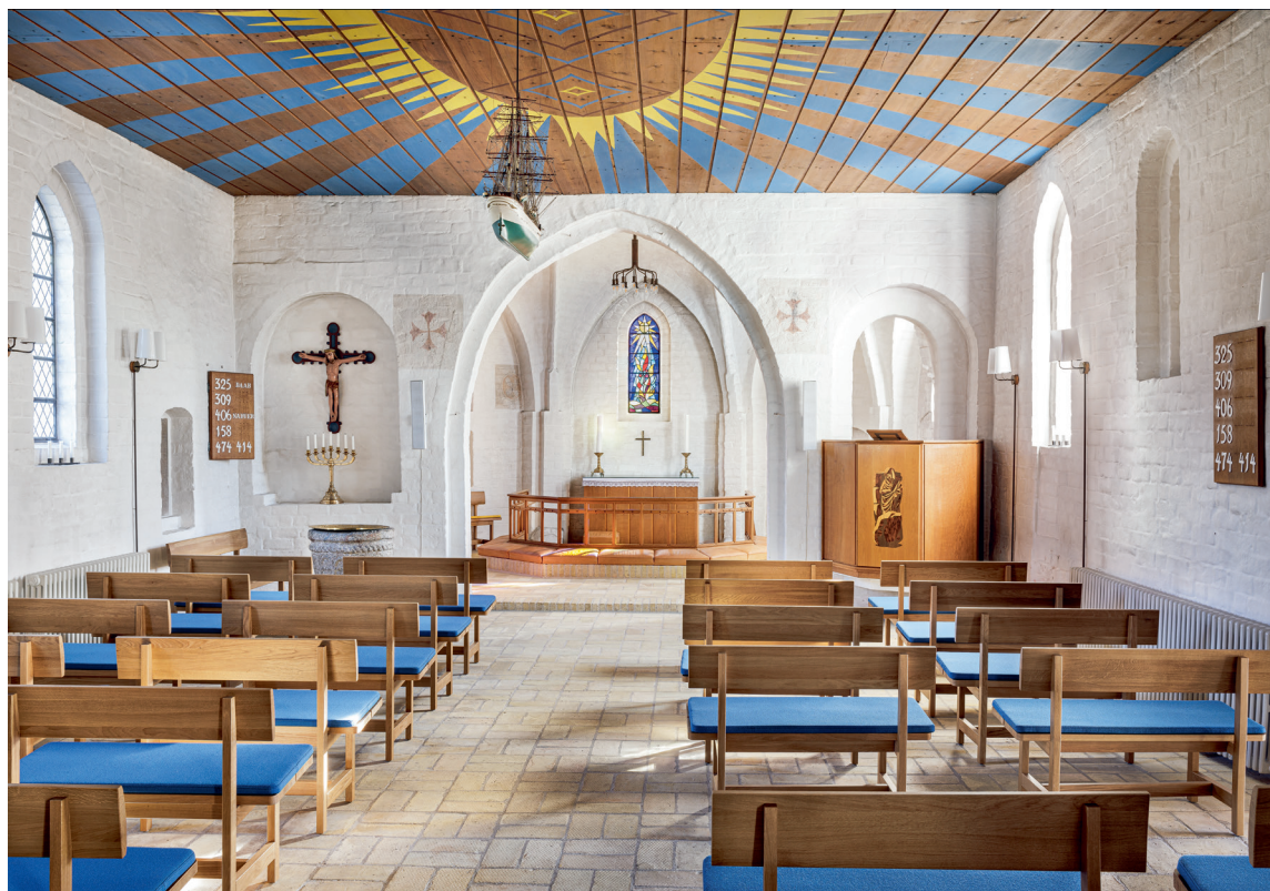
Fig. 41. Indre set mod øst. Foto Arnold Mikkelsen 2023. – Interior looking east.
