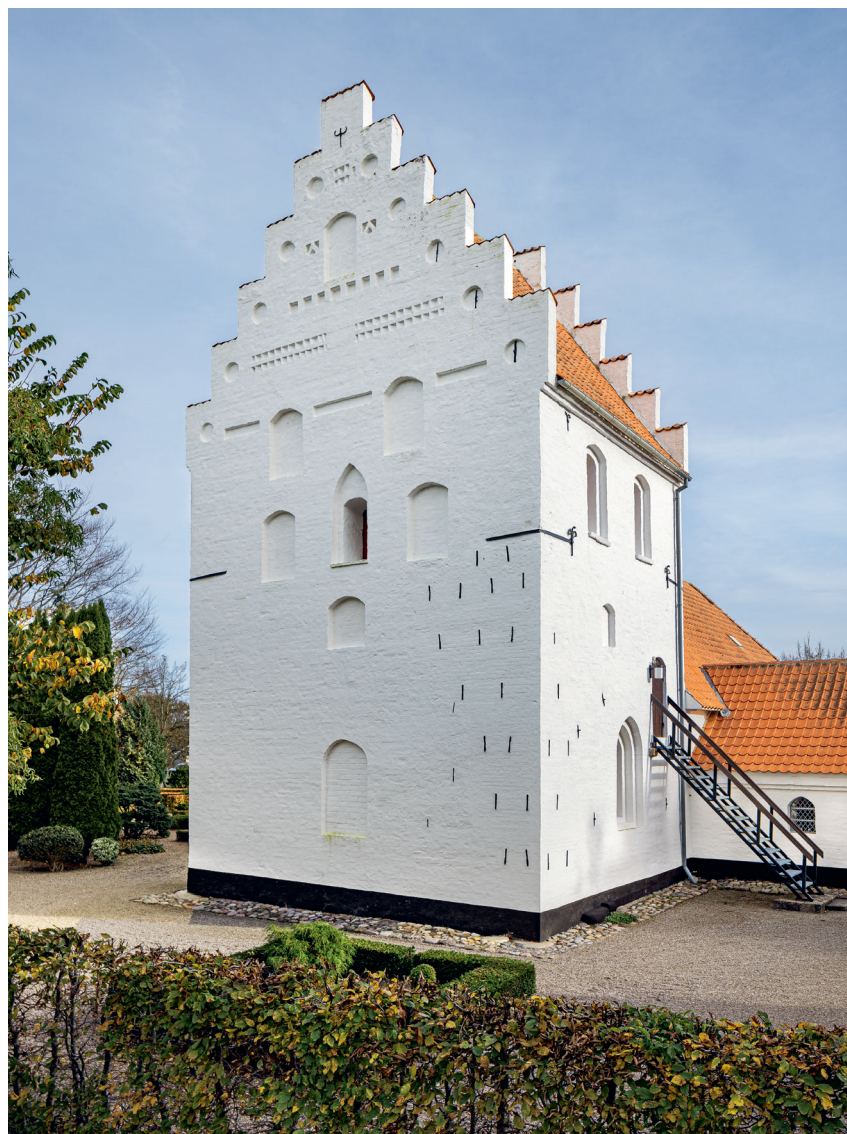
Fig. 17. Tårnet set fra sydvest (s. 3861). Foto Arnold Mikkelsen 2022. – Tower seen from the south west.
