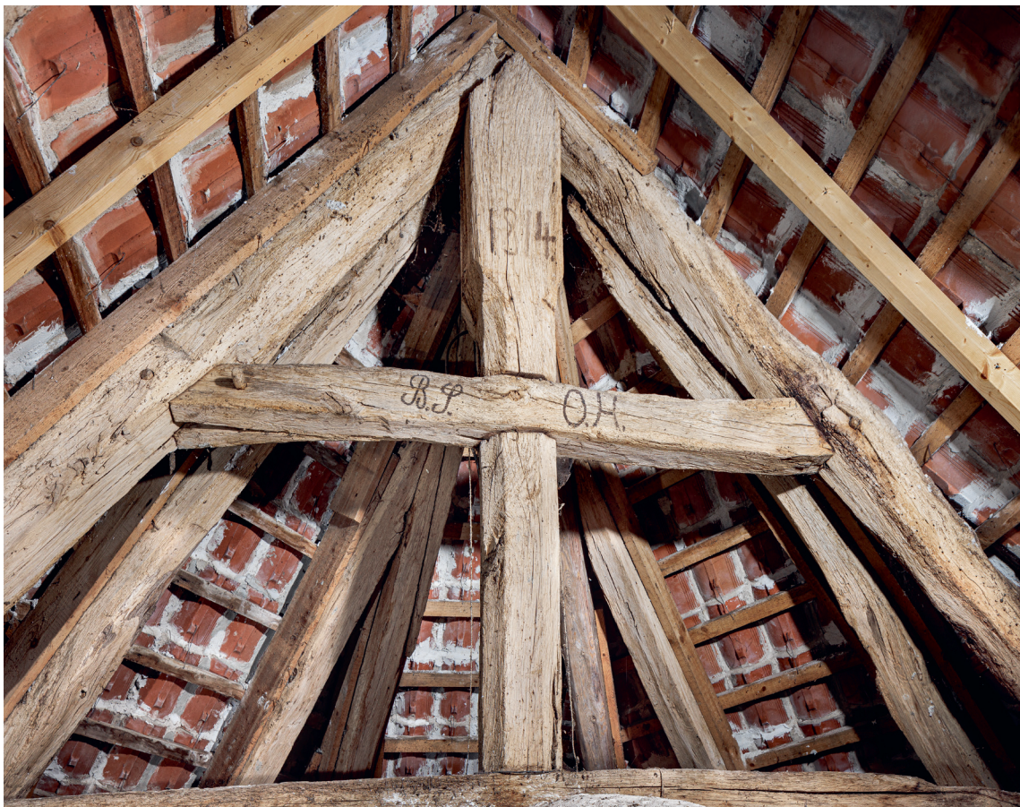
Fig. 26. Kongestolpe over koret set mod øst (s. 3869). Foto Arnold Mikkelsen 2022. – King post of the chancel looking east.
