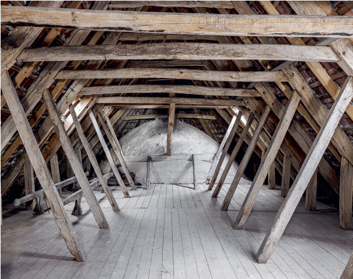
Fig. 27. Langhusets sengotiske tagværk set mod nordøst (s. 3869) samt ligbåre, antagelig 1700-tallet (s. 3897). Foto Arnold Mikkelsen 2022. – Late Gothic roofing of the nave church looking north east.
