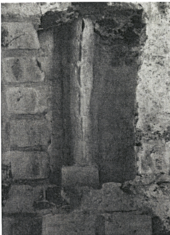
Fig. 21. Pille og ribbe til oprindeligt korhvælv gemt bag piller i det nuværende hvælv fremdraget under istandsættelsen 1958 (s. 3858). Efter Polk 1959 . – Pier and rib for the original chancel vault hidden behind piers in the current vault uncovered during the refurbishing of 1958.
