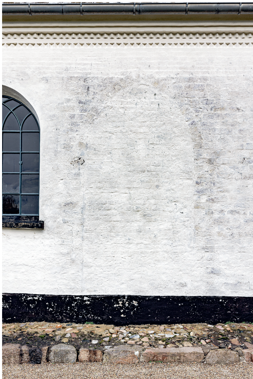
Fig. 11. Den tilmurede syddør set udefra (s. 3806). Foto Arnold Mikkelsen 2022. – Bricked-up south door seen from the outside.
