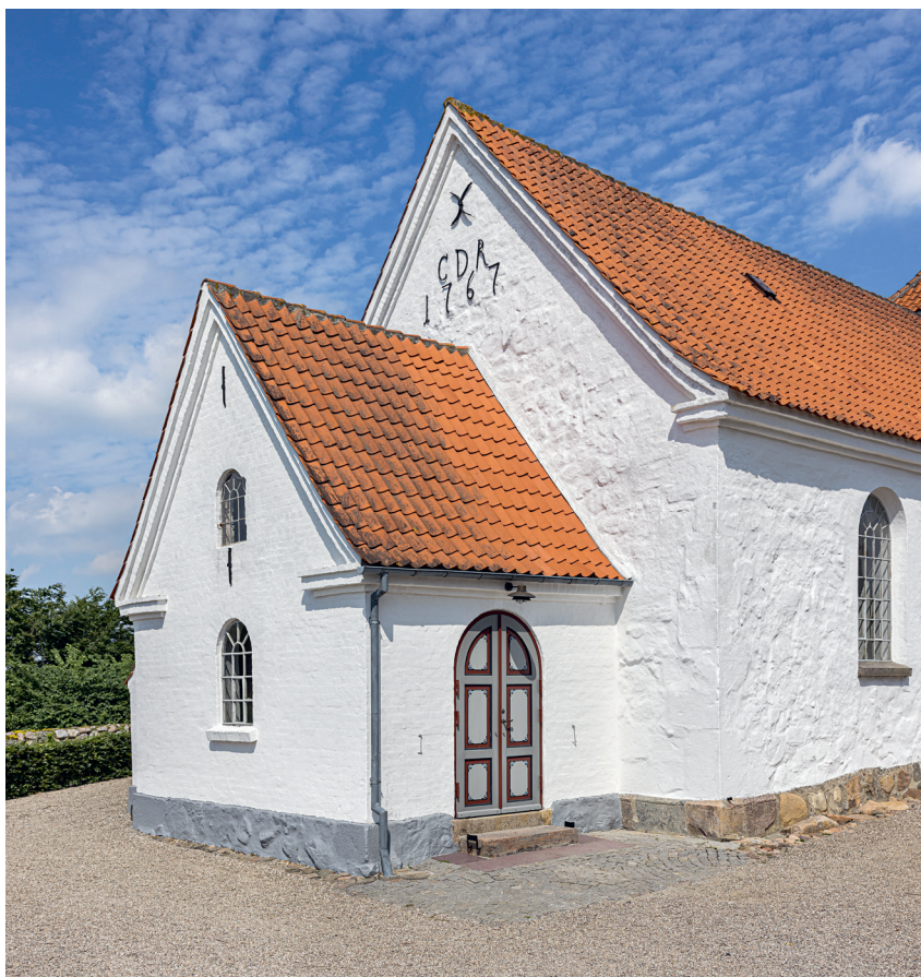
Fig. 12. Väbenhuset set fra sydvest (s. 3504). Foto Arnold Mikkelsen 2020. – The porch seen from the south west.
