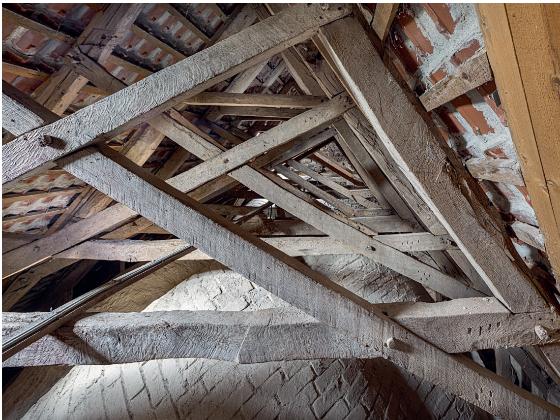
Fig. 17. Udsnit af skibets tagværk set mod vest (s. 3512). Foto Arnold Mikkelsen 2021. – Detail of the roofing of the nave looking west.
