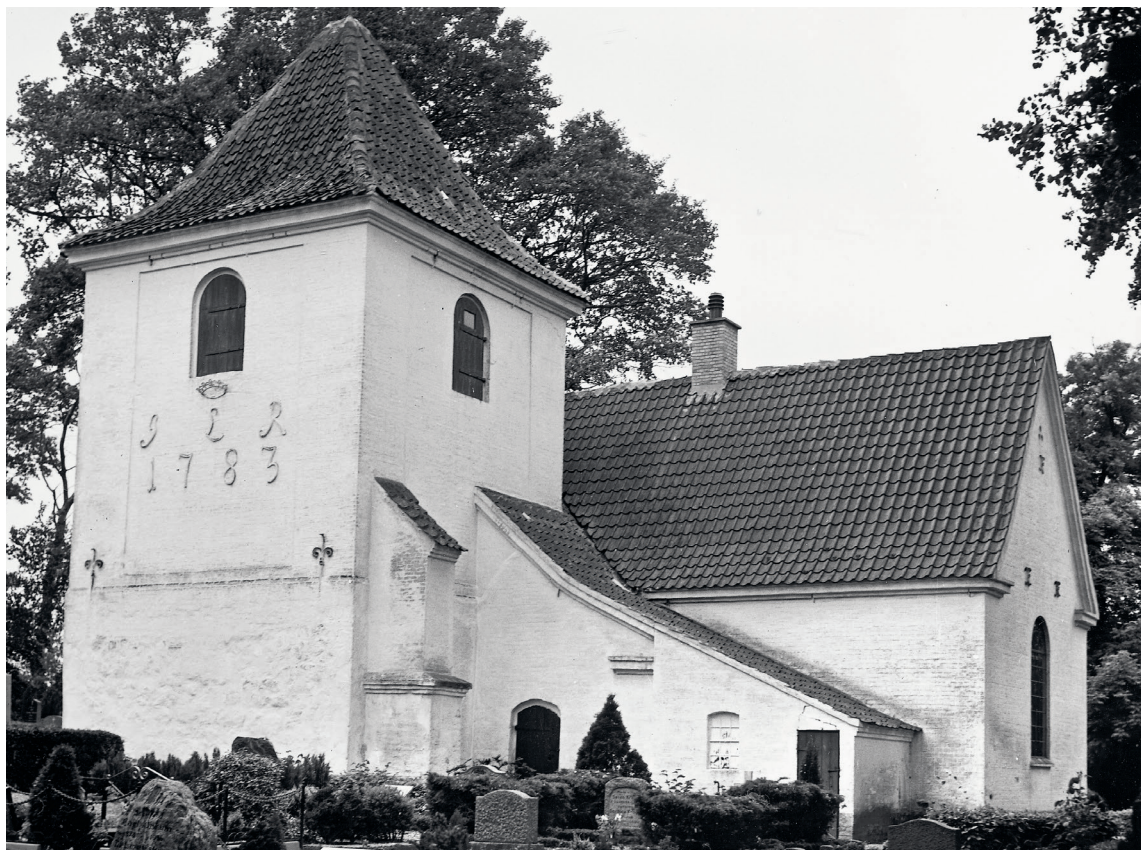
Fig. 15. Ydre set fra nordøst. Foto Hans Stiesdal 1964. – Exterior seen from the north east.
