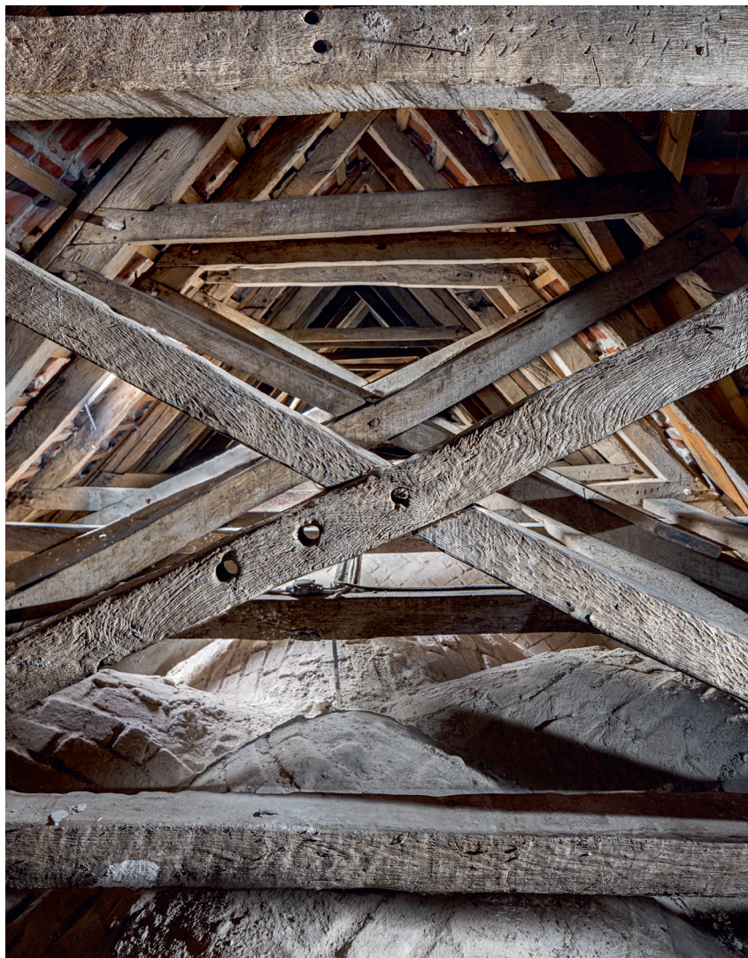
Fig. 19. Spor af muligt †klokkeophæng i skibets østligste spærfag set mod vest (s. 3514). Foto Arnold Mikkelsen 2021. – Traces of possible †bell frame in the easternmost truss of the nave, looking west.
