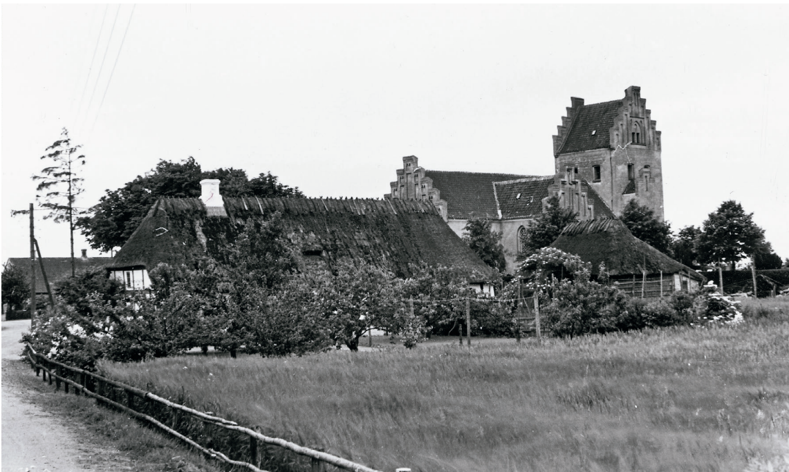
Fig. 20. Ydre set fra nordøst. Foto Erik Moltke 1943. – Exterior seen from the north east.
