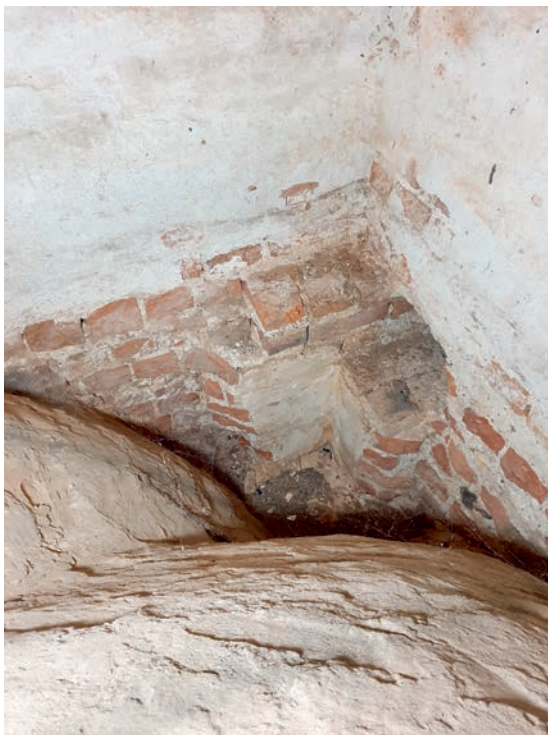
Fig. 12. Tårnets oprindelige murværk set fra loftet. Bemærk afsats og bjælkehul til det oprindelige træloft (s. 2894). Foto Pia K. Lindholt 2021. – Original masonry of the tower seen from the loft. Note the ledge and putlog hole for the original wooden ceiling.
