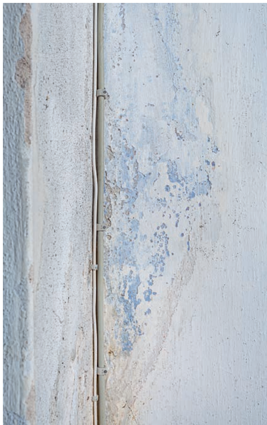
Fig. 45. Farvespor af bagmurenes oprindelige blå kalkning (s. 2896). Foto Arnold Mikkelsen 2020. – Traces of the original blue limewashing of the back walls.
