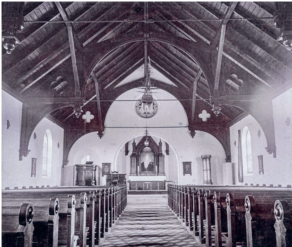
Fig. 14. Indre set mod øst, o. 1900. I Strynø Lokalhistoriske Arkiv. – Interior looking east, c. 1900.
