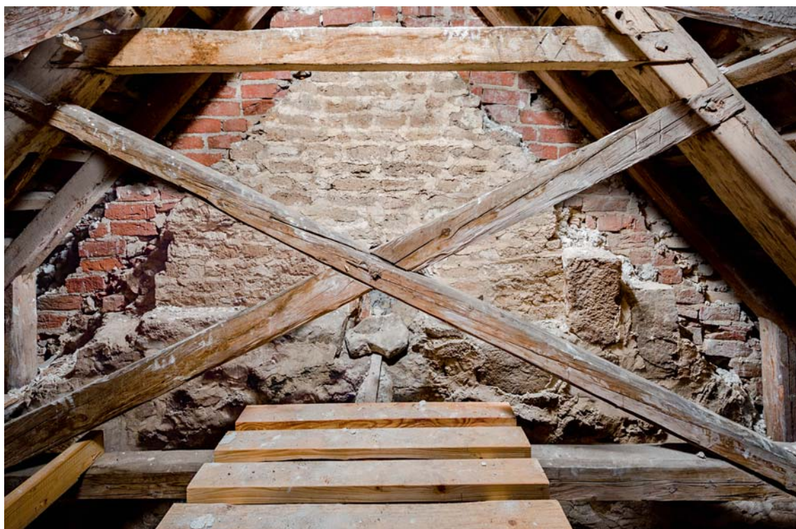
Fig. 10. Det romanske kors gavl set fra loftet mod øst (s. 1837). Foto Arnold Mikkelsen 2017. – The gable of the Romanesque chancel seen from the loft looking east.
