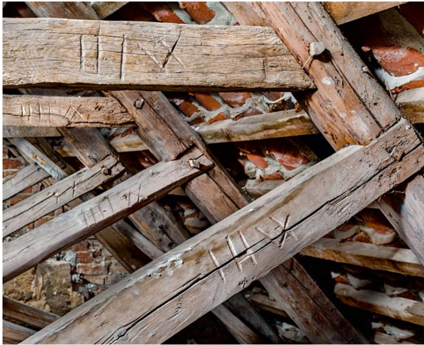
Fig. 21. Tømmermærker på korets tagværk (s. 1848). Foto Arnold Mikkelsen 2017. – Carpenters' marks on the chancel roofing.
