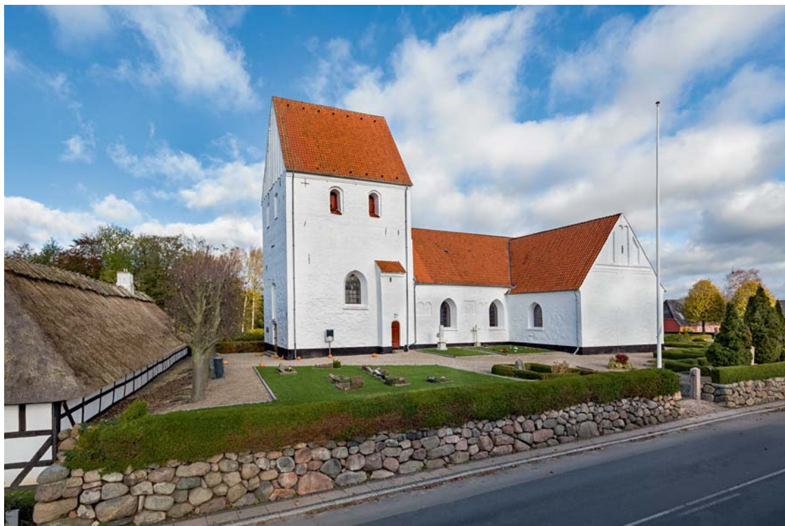
Fig. 1. Kirken set fra sydvest med præstegården vest for tårnet. Foto Arnold Mikkelsen 2017. – The church seen from the south west with the parsonage west of the tower.
