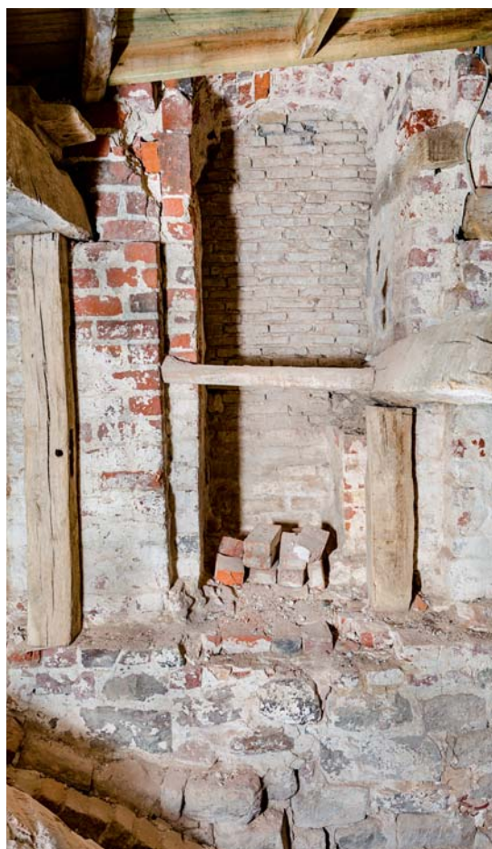
Fig. 14. Hejsedør i andet stokværk (s. 1841). Foto Arnold Mikkelsen 2017. – Pulley door on second floor.
