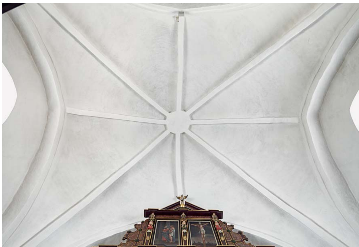
Fig. 16. Hvælv i koret (s. 1842). Foto Arnold Mikkelsen 2017. – Vault in the chancel.
