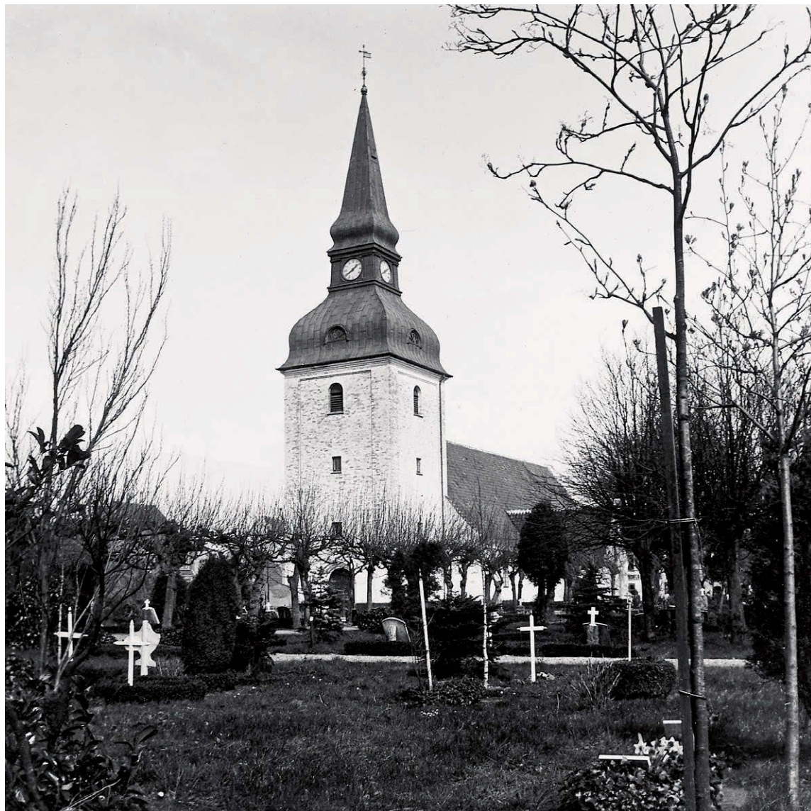
Fig. 17. Kirken med det nybyggede tårn set fra sydvest. Foto 1927 i NM. – The church with the newly built tower seen from the south west.
