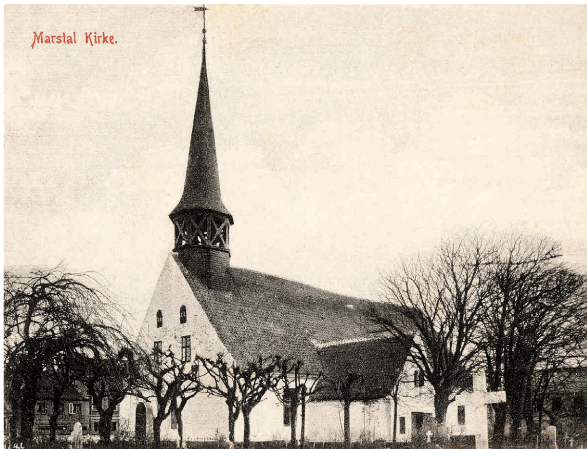
Fig. 13. Kirken med \dagger tagrytter set fra sydvest for opførelsen af tårnet 1920. Postkort o. 1900 i NM. – Church with \dagger tridge turrett seen from the south west before the erection of the tower in 1920.
