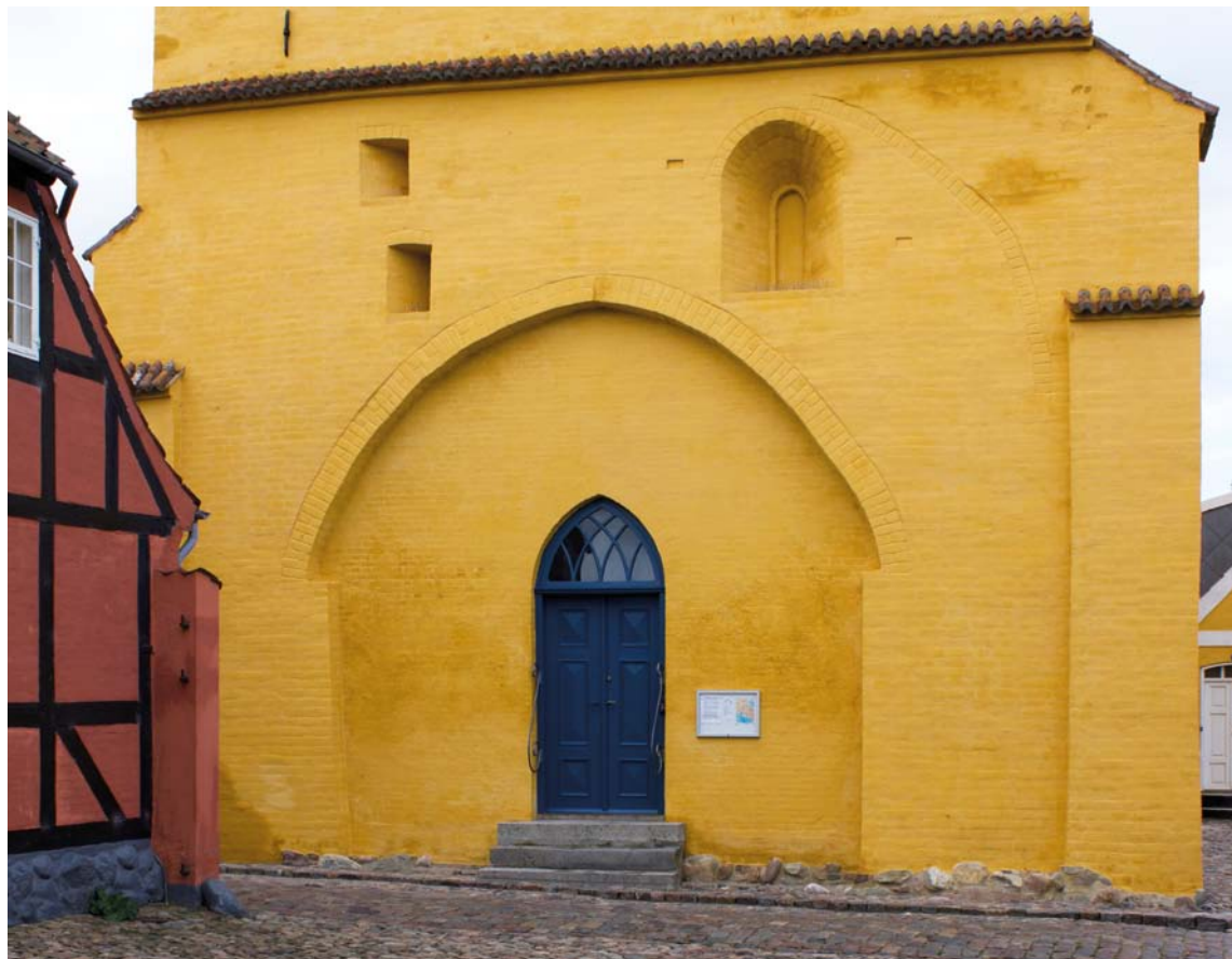
Fig. 1. Vestgavlen af \dagger skibet med vinduer og tårnarkade (s. 782, 785 ff.), set fra øst. Foto Thomas Bertelsen 2013. – West gable of nave with windows and tower arcade, seen from the east.
