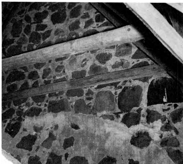
Fig. 3. Hagenbjærg. Spor efter det romanske kors trætondehvælv på triumfmurens østside (p. 2568).
