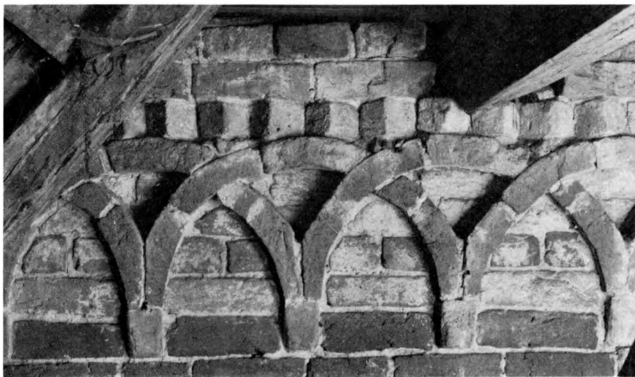
Fig. 7. Broager. Gesimsfrise på korets nordmur, under sakristitaget (p.2288).
