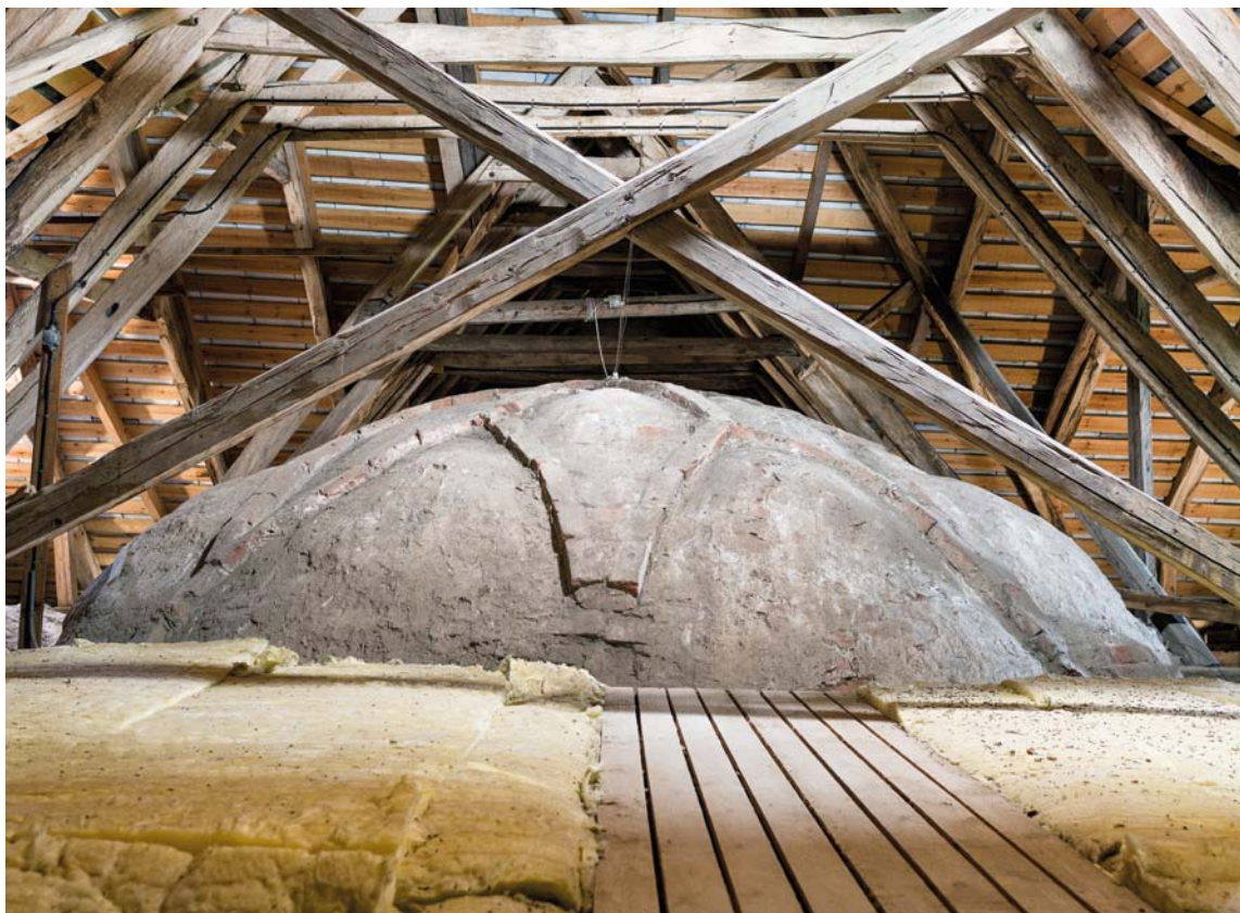
Fig. 17. Korsskæringens hvælv over loftet set fra vest (s. 2013). Foto Arnold Mikkelsen 2014. – Gewölbe der Vierung über der Decke aus Westen.
