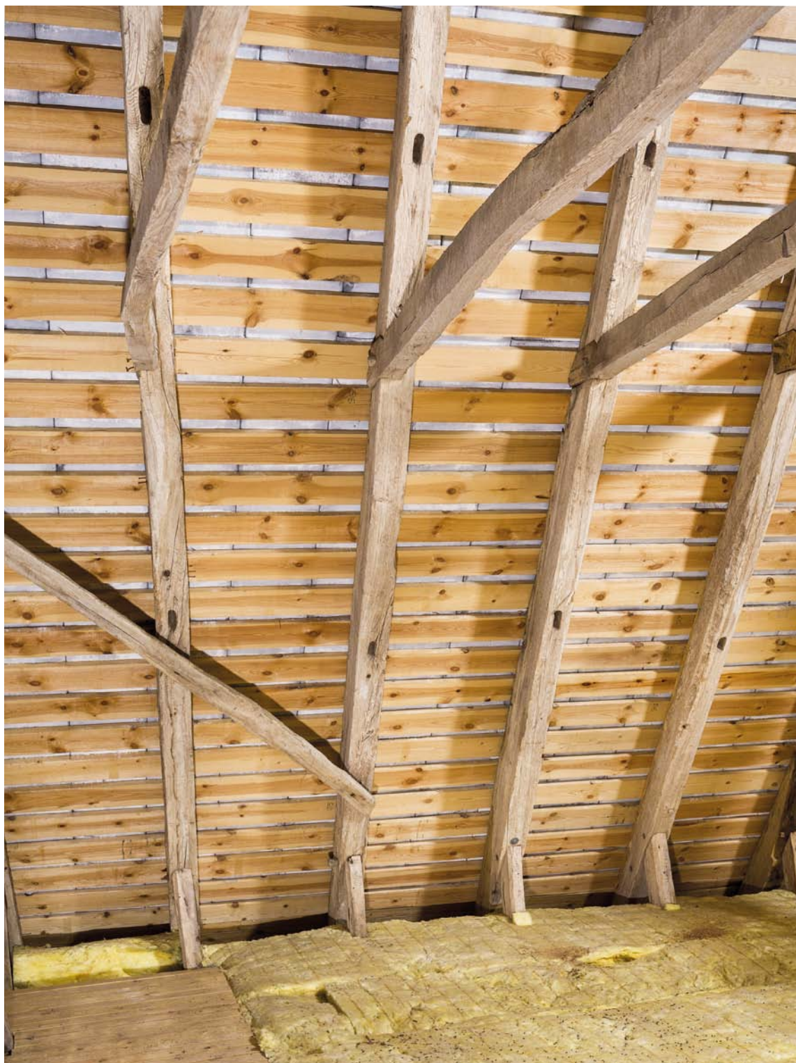
Fig. 30. Detalje af skibets tagværk med taphuller til ældre \uparrow spærstivere set fra syd (s. 2025). Foto Arnold Mikkelsen 2014. – Detail von dem Dachwerk des Schiffes.
