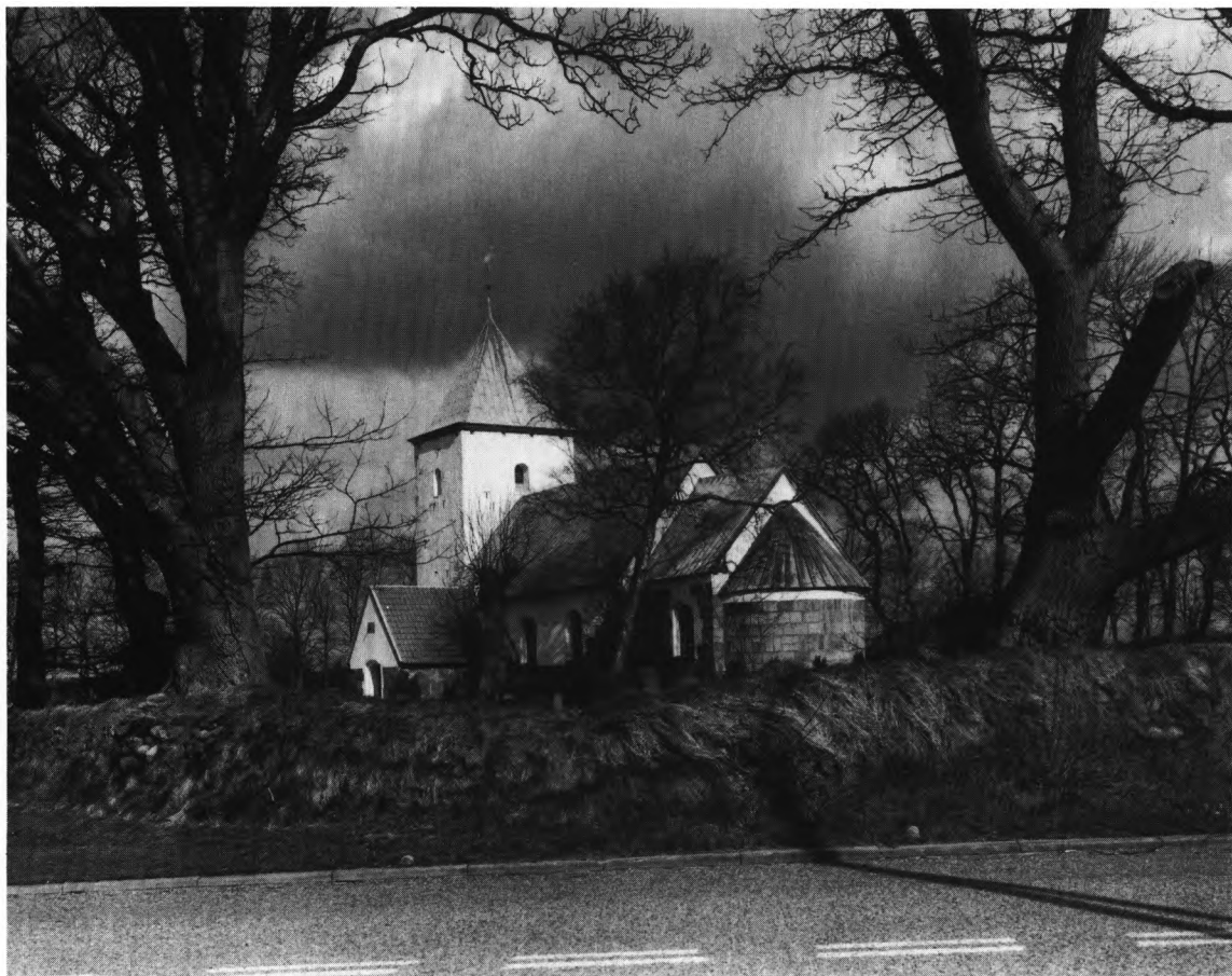
Fig. 1. Kirken set fra sydøst. NE fot. 1982 — Südostansicht der Kirche.
