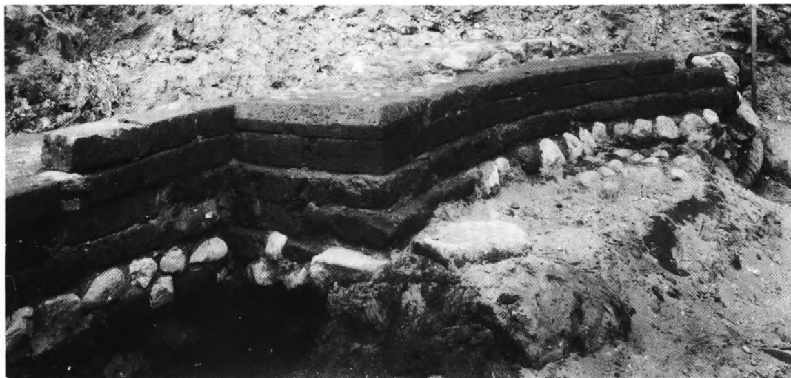
Fig. 6. S. Klemens kirke. Korets nordøstre hjørne og nordre del af apsis med indvendig skråkantsokkel af tuff, set fra sydvest (s. 835). C. M. Smidt fot. 1911. — St.-Klemens-Kirche. Nordöstliche Ecke des Chors und nördlicher Teil der Apsis mit inwendigem Fasensokkel aus Tuff, von Südwesten gesehen.
