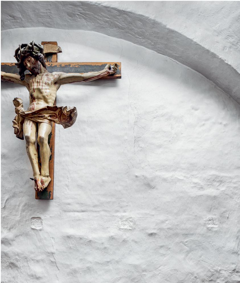
Fig. 40. Spor af \dagger dør (s. 6426) samt bomhuller til et \dagger herskabspulpitur (s. 6464) i det oprindelige kors nordvæg. Foto Arnold Mikkelsen 2021. – Traces of a \dagger door and beam holes to a \dagger family gallery in the original chancel's north wall.
