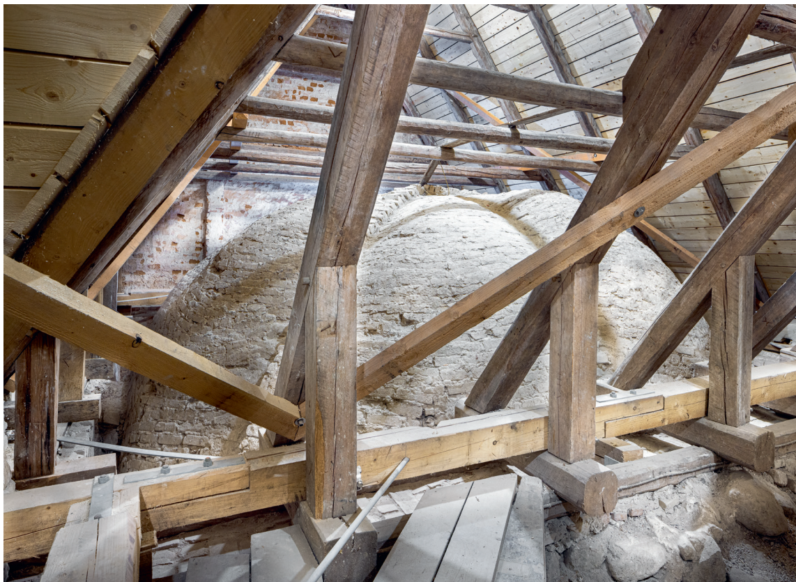
Fig. 36. Kapellets hvælv set mod nordøst (s. 6420). Foto Arnold Mikkelsen 2022. – Chapel vault looking north east.
