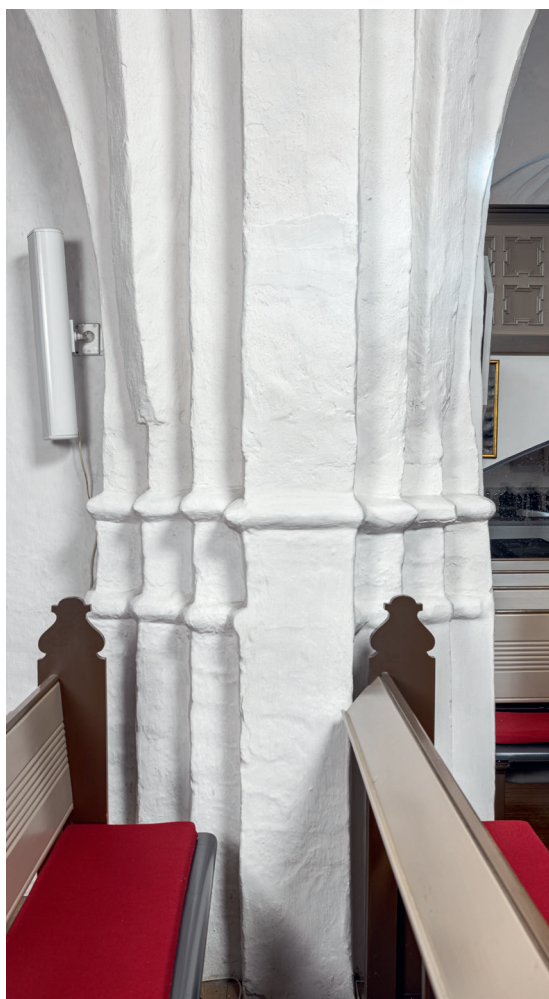
Fig. 32. Hvælpille i skibets nordside (s. 6417). Foto Arnold Mikkelsen 2021. – Vault pier in the nave's north side.
