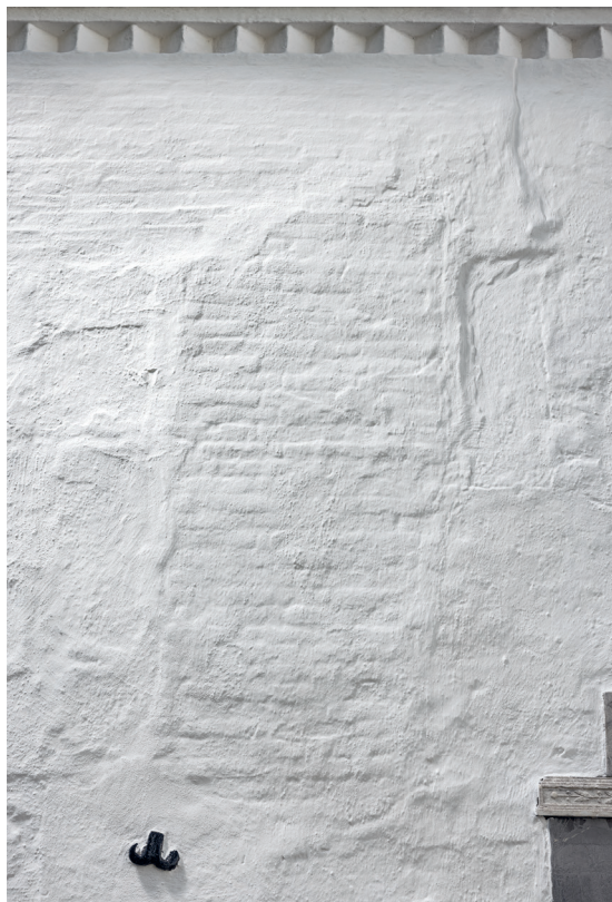
Fig. 39. Spor af \dagger dør (s. 6426) til et \dagger herskabspulpitur (s. 6464) i det oprindelige kors nordside. Foto Arnold Mikkelsen 2021. – Traces of a \dagger door to a \dagger family gallery in the original chancel's north side.
