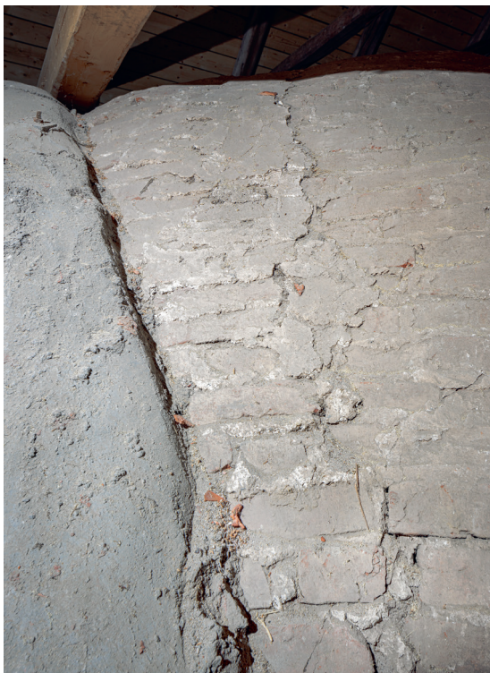
Fig. 112. Sammenstødet mellem korets og korforlængelsens hvælv (s. 6410). Foto Arnold Mikkelsen 2022. – Meeting of the vaults of the chancel and chancel extension.
