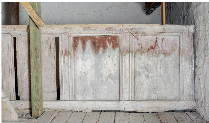
Fig. 121. Front- eller vægpanel fra \ddagger stolestader, 1600-tallet, nu i tårnets mellemstokværk (s. 6461). Foto Arnold Mikkelsen 2023. – Front or side panel from \ddagger pews, 1600s, now in the middle floor of the tower.
