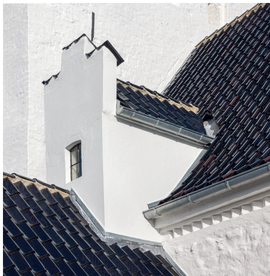
Fig. 41. Kvist, der giver adgang fra våbenhusets loft til skibets tagrum (s. 6414). Foto Arnold Mikkelsen 2021. – Dormer giving access from the loft of the porch to that of the nave.
