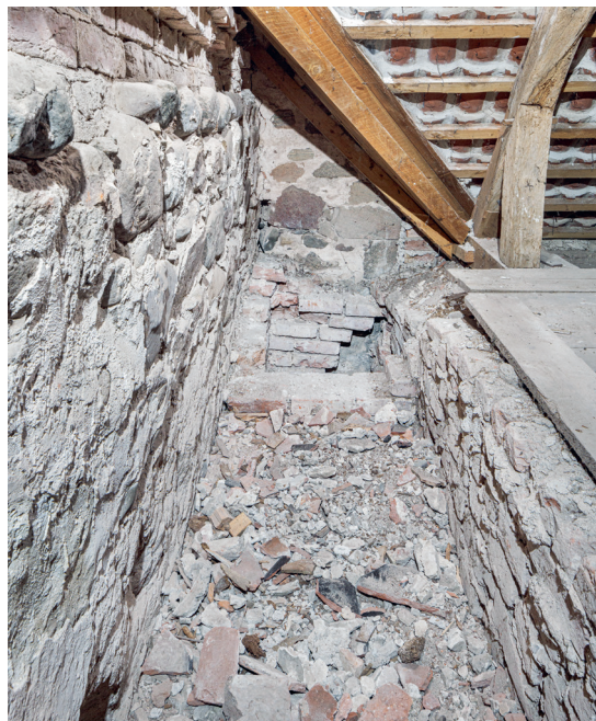
Fig. 42. Det romanske kors nordside og den murede skakt (jf. fig. 41, s. 6331) set mod vest i sakristiets loftsrum. Foto Arnold Mikkelsen 2022. – North side of the Romanesque chancel and the masonry shaft in the south west corner looking west in the loft of the sacristy.
