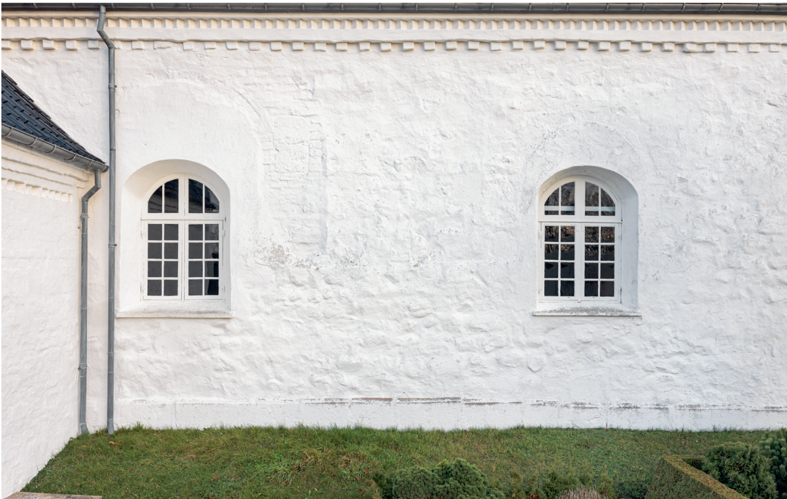
Fig. 48. Skibets sydside med spor af ældre \dagger vinduer (s. 6338). Foto Arnold Mikkelsen 2021. – The south side of the nave with traces of older \dagger windows.
