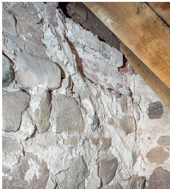
Fig. 13. Tagspor på det romanske kors forhøjede nordmur (s. 6313), set fra nordøst. Foto Arnold Mikkelsen 2022. – Roof remains on the heightened north wall of the Romanesque chancel, seen from the north east.
