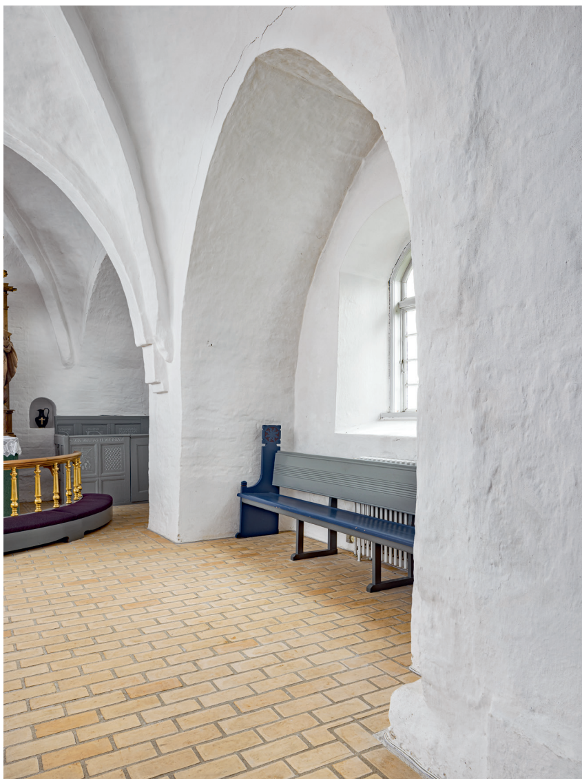
Fig. 18. Det udvidede kors syd væg (s. 6314), set mod sydøst. Foto Arnold Mikkelsen 2021. – The south wall of the extended chancel, looking south east.
