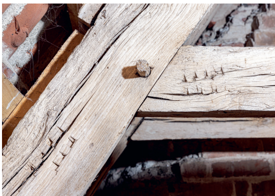
Fig. 50. Nummerering af korets tagværk, nordsiden (s. 6339). Foto Arnold Mikkelsen 2022. – Numbering of the chancel roofing, the north side.
