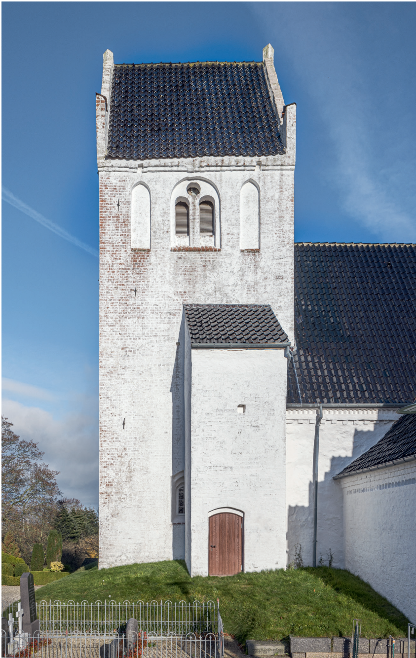
Fig. 29. Tårn (s. 6319) med trappehus (s. 6324) set fra syd. Foto Arnold Mikkelsen 2021. – Tower with stairwell seen from the south.
