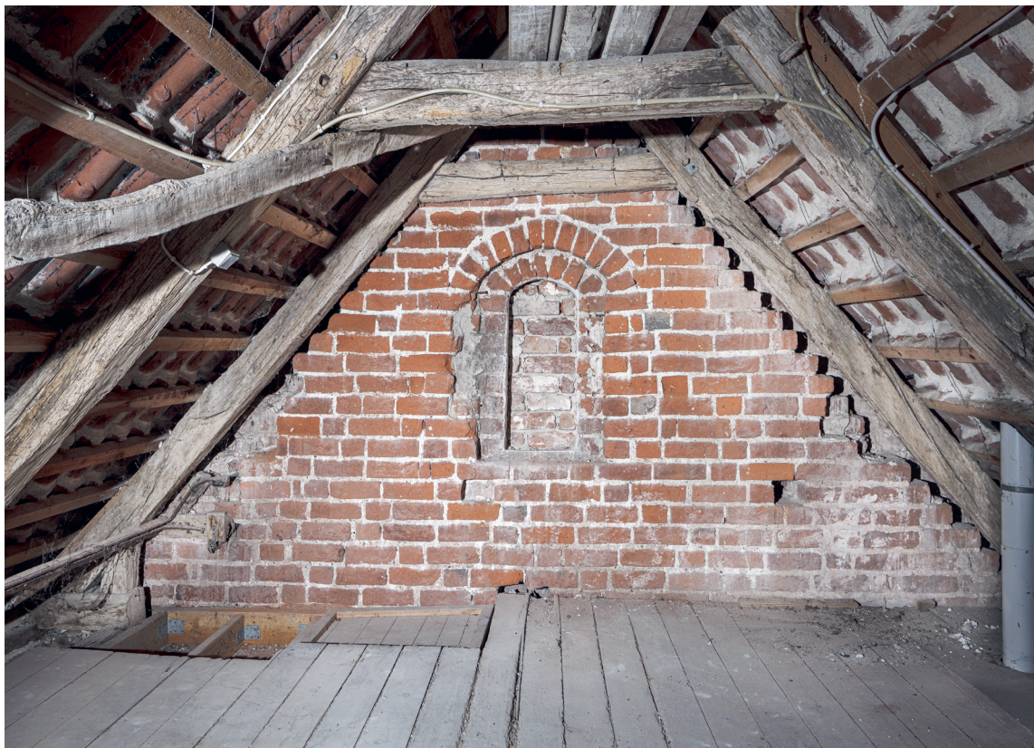
Fig. 51. Våbenhusets tagværk (s. 6339) og gavl med tglug (s. 6328), set mod syd. Foto Arnold Mikkelsen 2021. – Roofing and gable of porch with tpeephole, looking south.
