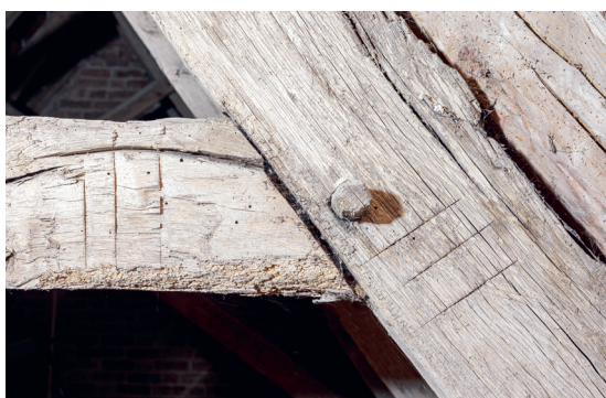
Fig. 52. Nummerering af korets tagværk, sydsiden (s. 6339). Foto Arnold Mikkelsen 2022. – Numbering of the chancel roofing, the south side.
