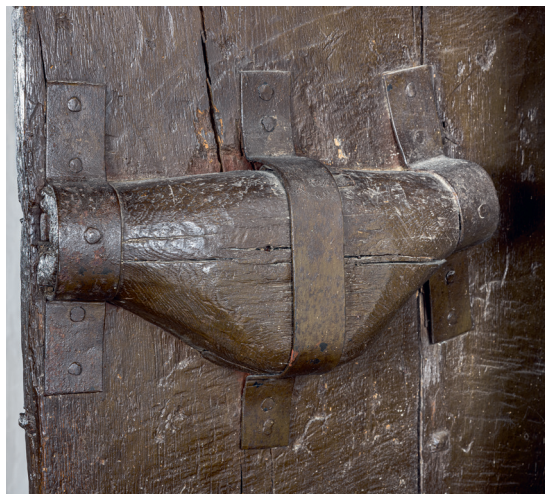
Fig. 88. Låsekasse (med sekundære jernbeslag), detalje af jernbunden dørfloj 1489 (s. 6370, jf. fig. 89). Foto Arnold Mikkelsen 2021. – Lock chest (with secondary iron mounting), detail of iron-bound door wing, 1489 (cf. fig. 89).
