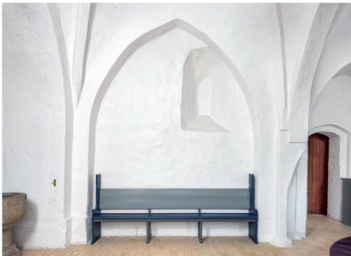
Fig. 12. Det romanske kors nordvæg med oprindeligt \dagger vindue (s. 6311), samt skjoldbue fra ældre, sekundært \dagger hvælv i koret (s. 6313), set mod nord. Foto Arnold Mikkelsen 2021. – North wall of the Romanesque chancel with original \dagger window, as well as wall rib from older, secondary \dagger vault in the chancel, looking north.
