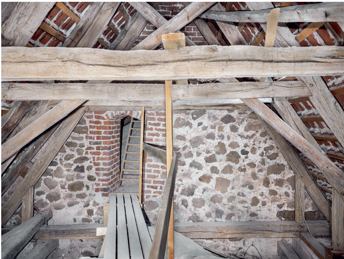
Fig. 24. Triumfgavlen med gavlspar og med dør (s. 6318) set mod vest. Foto Arnold Mikkelsen 2022. – Chancel arch gable with gable rafters and with door looking west.
