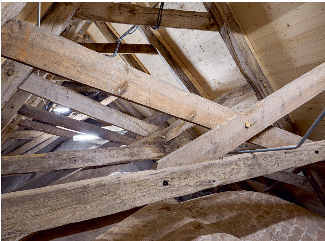
Fig. 21. Skibets tagkonstruktion (s. 5709). Foto Arnold Mikkelsen 2019. – The roof structure of the nave.
