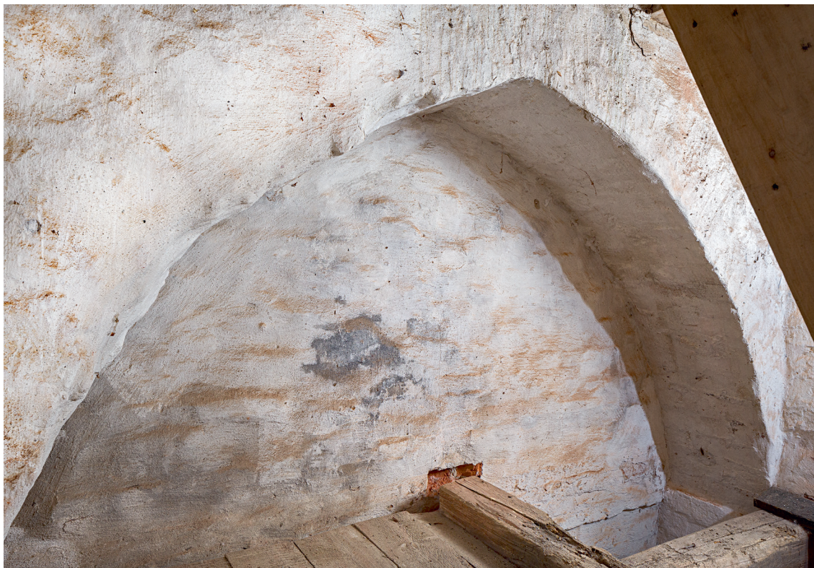
Fig. 15. Spidsen af den blændede arkade i tårnets vestmur (s. 5704). Foto Arnold Mikkelsen 2019. – Tip of the bricked-up arcade in the west wall of the tower.
