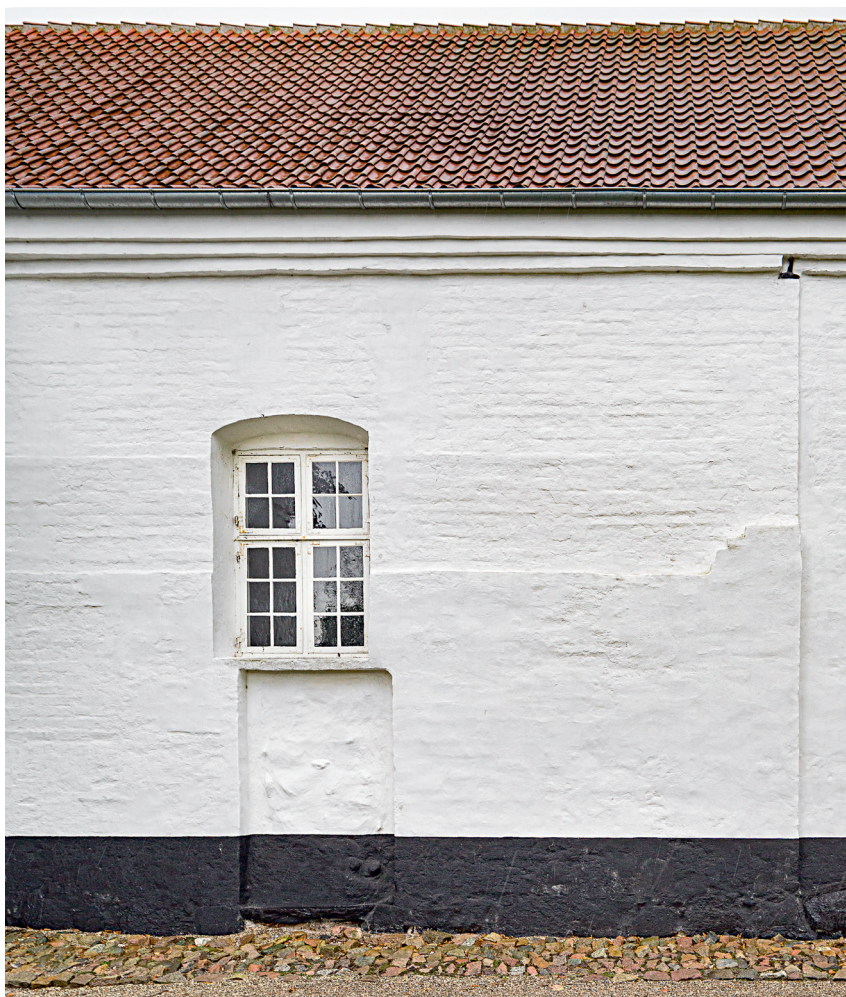
Fig. 9. Blændet dør (s. 5697) og afsæt i skibets nordfacade (s. 5699-5700). Foto Arnold Mikkelsen 2019. – Bricked-up door and offset in the north façade of the nave.
