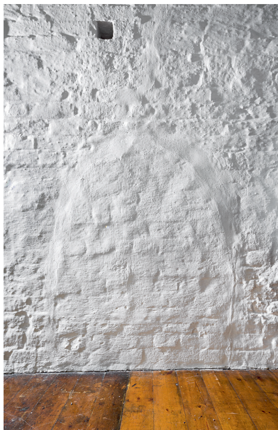
Fig. 12. Blændet spejl over dør eller vindue i vestforlængelsens vestvæg (s. 5701). Foto Arnold Mikkelsen 2019. – Bricked-up recess above door or window in the west wall of the interior of the west extension.
