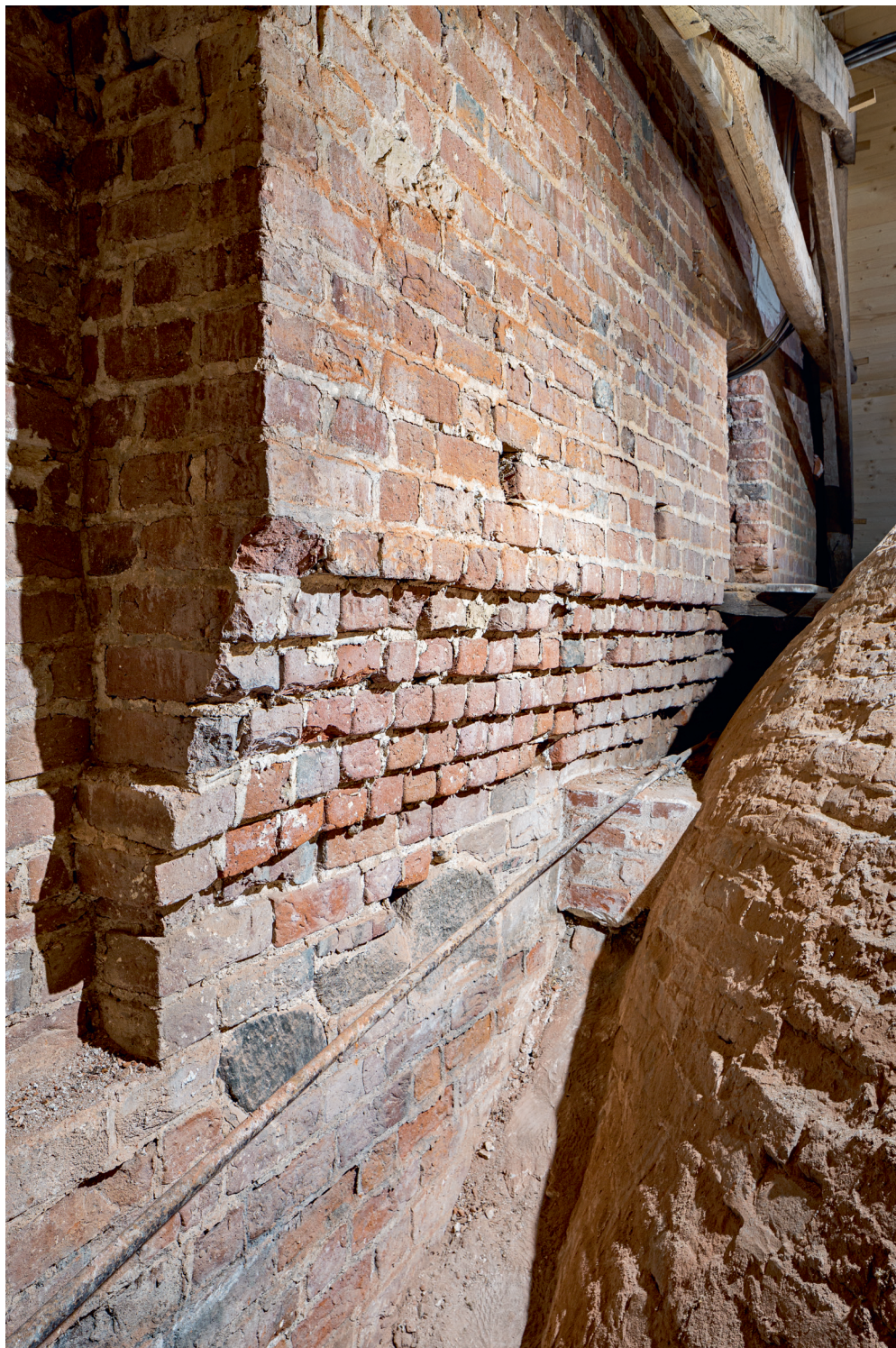
Fig. 13-14. 13. Tårnets østmur, der bæres af udkragninger på indersiden af vestforlængelsens gavl (s. 5704). 14. Tårnet set fra vest (s. 5701). Foto Arnold Mikkelsen 2019. – 13. The east wall of the tower resting on the west wall of the western extension of the nave. 14. The tower seen from the west.
