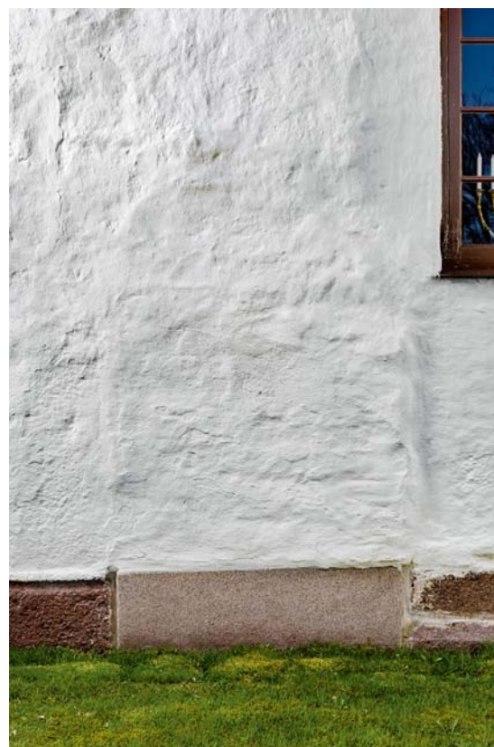
Fig. 8. Den blændede norddør (s. 4905). Foto Arnold Mikkelsen 2018. – Bricked-up north door.
