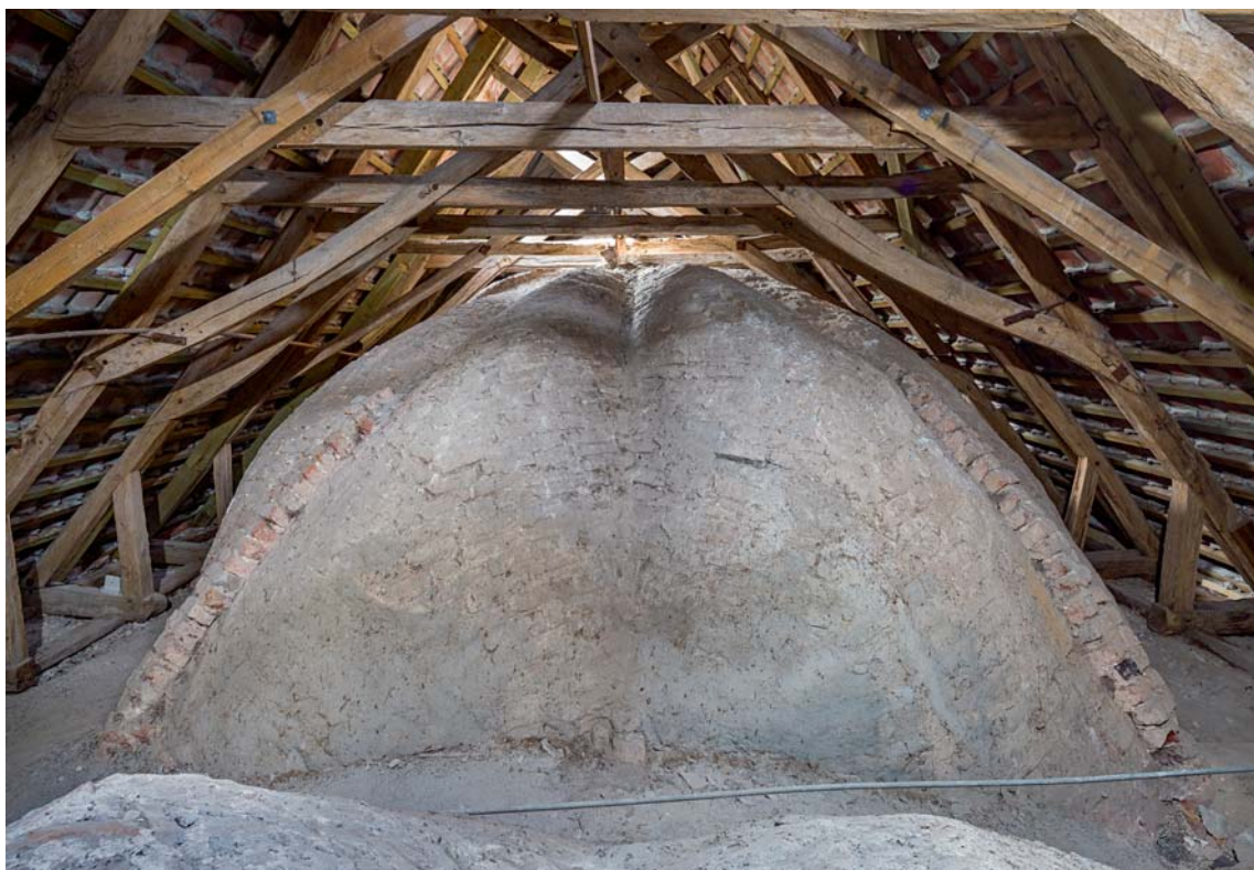
Fig. 18. Skibets tagstol (s. 4916) og hvælv (s. 4906). Foto Arnold Mikkelsen 2018. – Roof truss and vaulting of nave.
