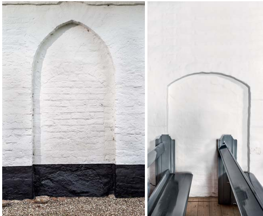
Fig. 10-11. Kirkens blændede norddør (s. 3451). 10. Ydre. 11. Indre. Foto Arnold Mikkelsen 2015. – Bricked-up north door of church. 10. Outside. 11. Inside.
