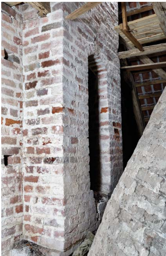
Fig. 11. Messeklokkespiret, o. 1515-30, set mod sydøst fra skibets loft (s. 3016). Foto Arnold Mikkelsen 2014. – Mass bell spire, c. 1515-30, seen towards the south east from the ceiling of the nave.
