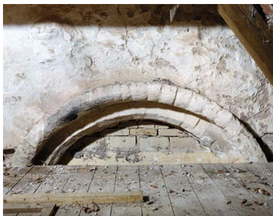
Fig. 12. Den blændede syddør set fra ligkappellets loft (s. 3014). Foto Arnold Mikkelsen 2014. – Bricked-up south door seen from the loft of the mortuary chapel.
