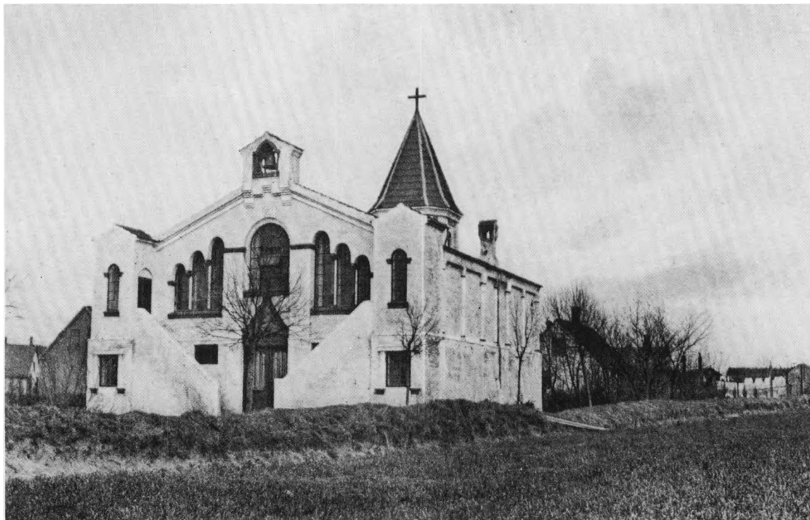
Fig. 1. Ydre, set fra sydvest. Postkort fra 1900'ernes første årti. NM2 - Exterior seen from the south-west.
