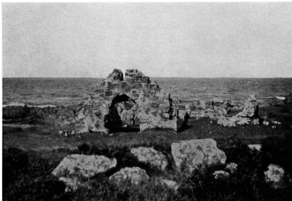
Fig. 1. Salomons kapel. Ruinen set fra syd før restaureringen.
