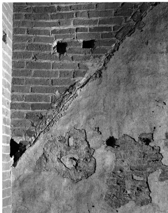
Fig. 14. Udsnit af skibets vestgavl (s. 4592) i tårnets mellemstokværk, (s. 4597). KdeFL fot. 1996. - Section of the west gable of the nave as seen in the second storey of the tower.
