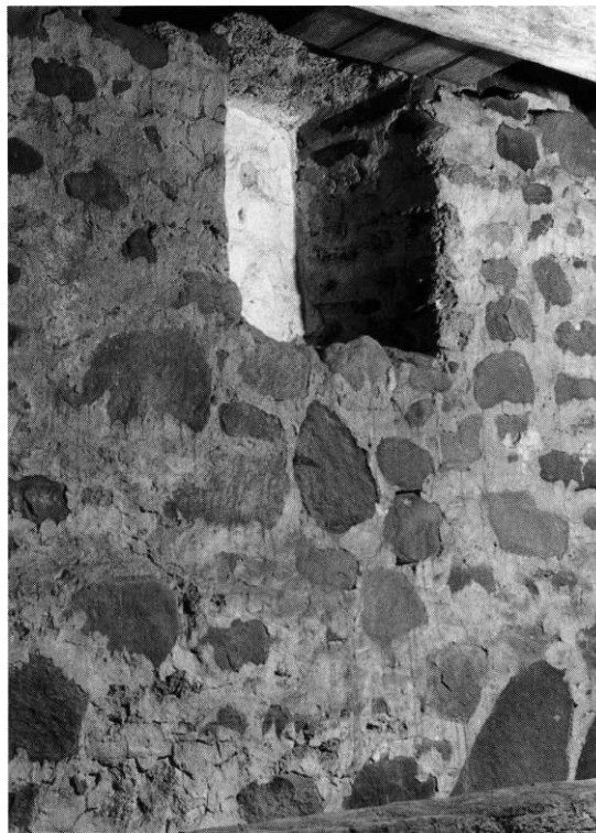
Fig. 7. Udsnit af korets østre taggavl, inderside med vindue (s. 4595). Mogens Svenning fot. 1973. - Section of the east gable of the chancel.
