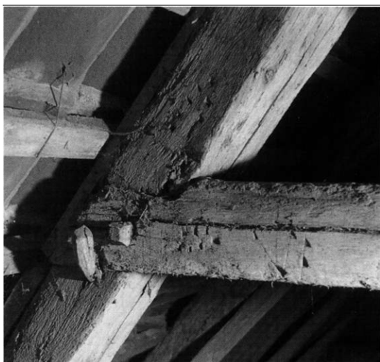
Fig. 13. Detaljer fra skibets tagværk. Nummereringer og samlinger mellem spær og hanebånd (s. 4600). Mogens Svenning fot. 1973. - Details of the roof construction of the nave. Joinings of tie-beams and rafters.
