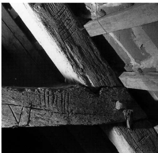
Fig. 13. Detaljer fra skibets tagværk. Nummereringer og samlinger mellem spær og hanebånd (s. 4600). Mogens Svenning fot. 1973. - Details of the roof construction of the nave. Joinings of tie-beams and rafters.
