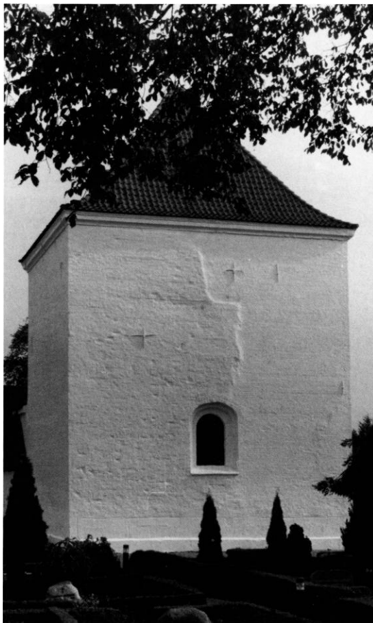
Fig. 14. Tårnets stærkt reparerede vestside. KdeFL fot. 1992. - The west facade of the tower.
