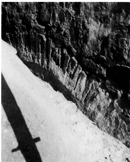
Fig. 9. Udsnit af vestsiden af korets østgavl med stik over åbningen til den forsvundne apsis (s. 3940, jfr. fig. 6). Ole Brusendorff og Anne-Beate Nyrop fot. 1938. - Section of the west side of the chancel's east gable including voussours above the opening to the former apse, cf. figs. 4, 7 and 10.
