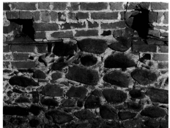
Fig. 13. Udsnit af nordvæggens murværk i tårnets mellemetage (s.3942). KdeFL fot. 1993. - Section of masonry in the second storey of the tower.
