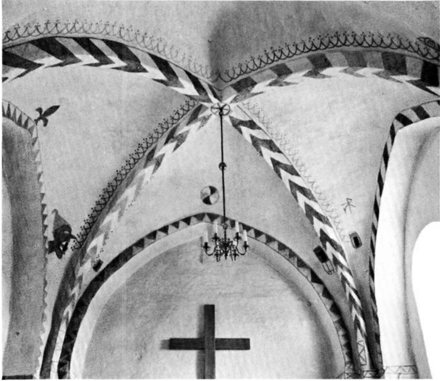
Fig. 6. Kasted. Korhvælvets kalkmalede udsmykning (p. 1598). - Mural decoration of chancel vaulting.
