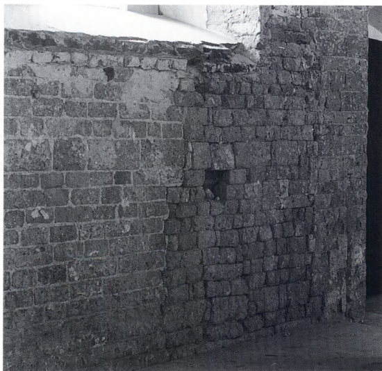
Fig. 8. Detalje af skibets sydvæg befriet for puds (s. 3312), set mod sydvest. Mogens Larsen fot. 1976. – Details von dem von Putz befreiten Südwall des Schiffes.
