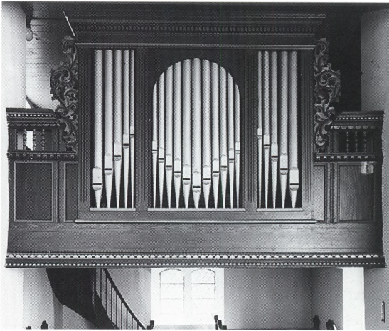
Fig. 34. Orgelfacaden med de originale piber fra 1841; sidefelternes piber var attrapper af sølvbronzeret træ. De lodrette sprossers bemaling efterlignede kannelerede pilastre (s. 3338). Mogens Larsen fot. 1970. – Orgelprospekt mit den originalen Prospektpfeifen aus dem Jahre 1841; die Pfeifen in den Seitenfeldern waren Attrappen aus silberbronzierterem Holz. Die Bemalung der senkrechten Baluster bildeten kannelierte Pilaster nach.
