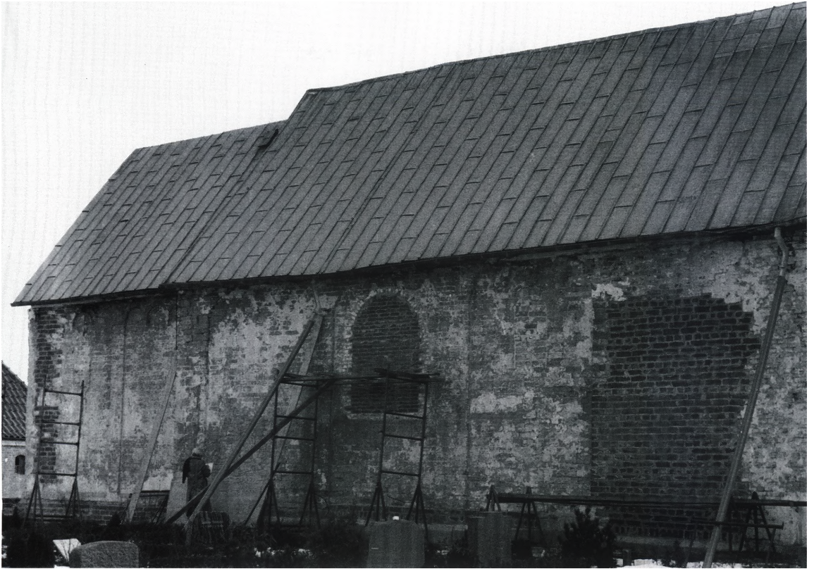
Fig. 11. Nordsiden af kor og skib under restaurering (s. 3318), set fra nordvest. EM fot. 1978. – Nördliche Chor- und Langhauswand während Restaurierung, Nordwestansicht.
