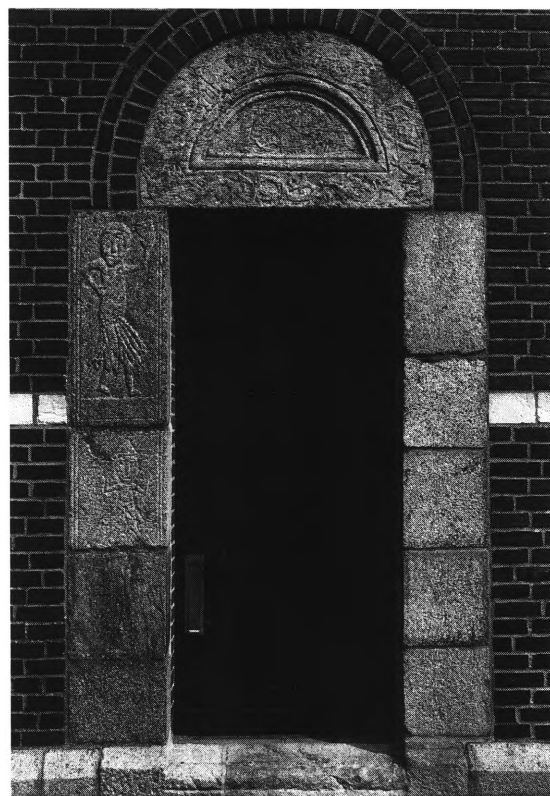
Fig. 8. Romansk portal, oprindelig præstedør i den gamle tårn kirke (s. 2881). NE fot. 1993. – Romanischer Portal, ursprünglich Priestertür der alten tårn kirche.
