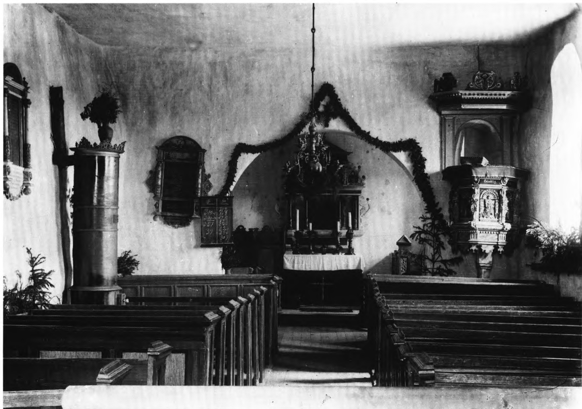
Fig. 22. Den gamle kirkes indre set mod øst kort før nedrivningen. L. Poulsen fot. Det kgl. Bibliotek. – Immeres der alten Kirche gegen Osten. Aufnahme kurz vor dem Abbruch.
