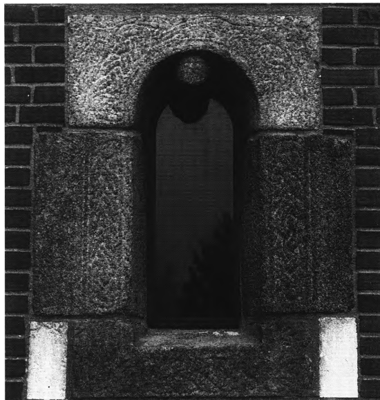
Fig. 7. Romansk vindue, overført fra koretets nordmur i den nedrevne tårn kirke (s. 2884). NJP fot. 1993. – Romanisches Fenster, ursprünglich Chorfenster in der Nordwand der alten tårn kirche.
