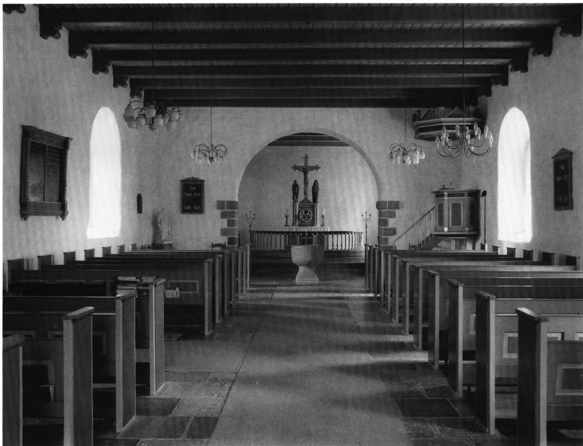
Fig. 10. Indre set mod øst. NE fot. 1986. – Innenansicht nach Osten.
