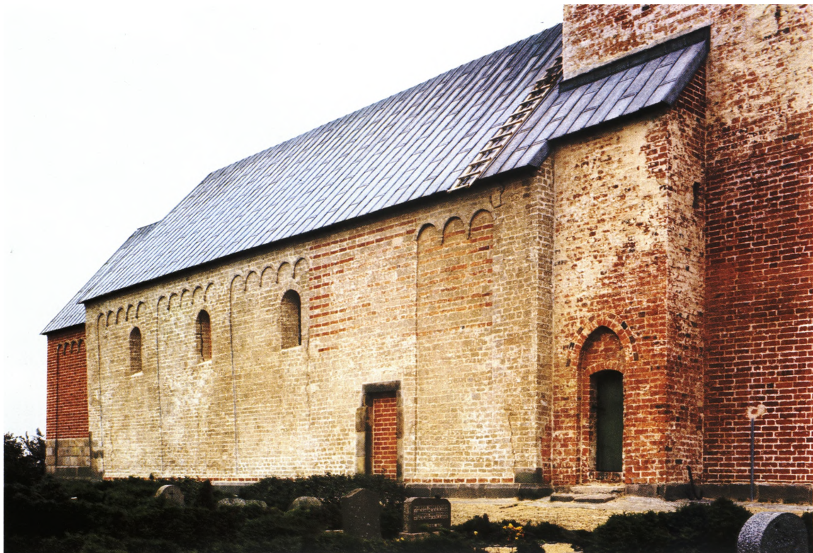
Fig. 10. Kirkens nordside, set fra nordvest, da kirkens facader i sommeren 1966 ved sandblæsning var renset for puds og kalk. Det ombyggede kor, af teglsten, er fra 1891, hvorimod skibet har bevaret sit middelalderlige murværk af vekselvis tuff og tegl (sml. fig. 9). Til højre i billedet ses det senmiddelalderlige tårn med trappehus, af tegl. Knud J. Krogh fot. 1966. – Nordseite der Kirche von Nordwesten nach Sandstrahlen-Reinigung der Mauern von Putz und Kalk 1966. Der umgebaute Chor aus Backstein stammt aus dem Jahre 1891, wogegen das aus Tuff und Backstein bestehende mittelalterliche Mauerwerk im Langhaus erhalten geblieben ist (vgl. Abb. 9). Rechts im Bild der spätmittelalterliche Turm mit Treppenhaus aus Backstein.
