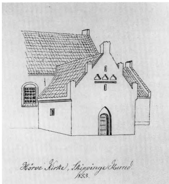
Fig. 22. Våbenhuset set fra sydvest (s. 2526). Tegning af Burman Becker 1853. Det kongelige Bibliotek. - Porch seen from the south-west.
