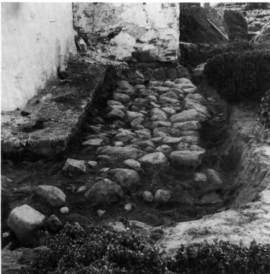
Fig. 51. Fundament til planlagt korudvidelse (s. 2529). Kai Uldall fot. 1925. - The foundation of proposed enlargement of the chancel.
