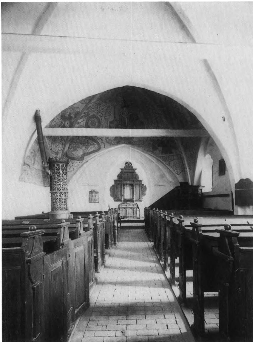
Fig. 24. Indre set mod øst. †Kakkelovn og †ankerbjælker. NM2 fot. 1895. - Interior to the east. †Furnace and †anchor beams.
