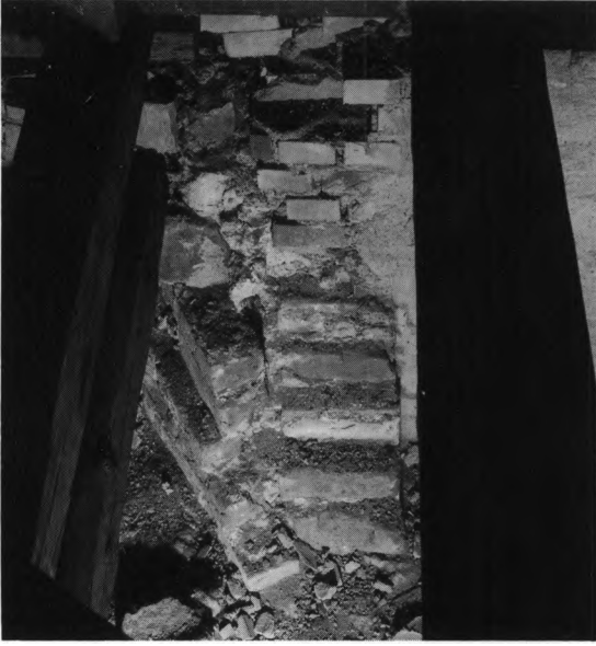
Fig. 17. Rest af rundskibets murkroner af tegl (s. 2519) over skibets hvælv i nordøsthjørnet, til højre skibets sekundære tåstgavl (s. 2527). Mogens Vedso fot. 1992 - Relic of round church masonry above the nave's vaults in the north-east corner, to the right the tåstgable of the nave.
