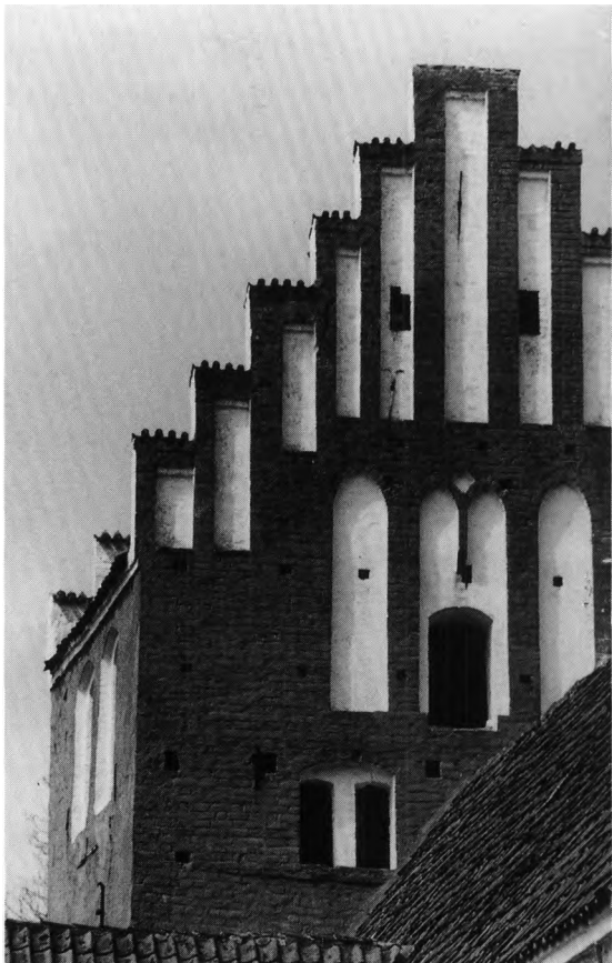
Fig. 9. Udsnit af tårnets østside med oprindeligt glamhul og blændinger (s. 1722) under forhøjelsens kamtakkede blændingsgavl (s. 1726). Marinus Andersen fot. o. 1964. - Detail of the east wall of the tower with original belfry light and blind recesses beneath the heightened corbie-stepped gable.
