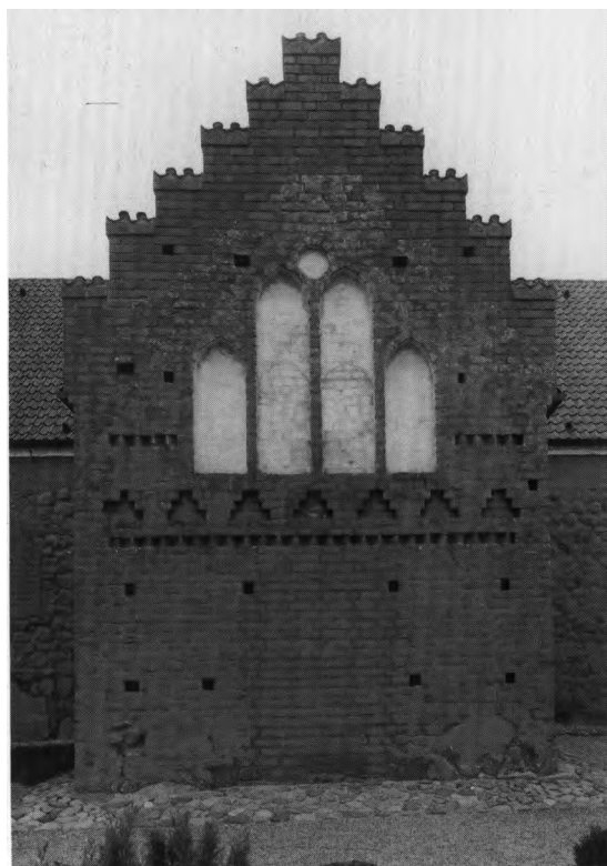
Fig. 10. Gammelrands kapel. Gavlens oprindelige blændinger (s. 1723) er bevaret under den kamtakke-ede forhøjelse (s. 1725). NE fot. 1981. - The Gammelrands Chapel. The original blind recesses of the gable are preserved beneath the corbie-stepped addition.
