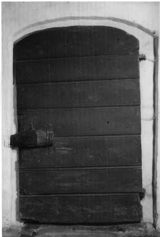
Fig. 61. Dørfløj nr. 3, indgangsdør til nordre våbenhus. Middelalderlig, men senere forsynet med vandrette revler på den indvendige side, hvor der sidder genanvendt lås af træ (s. 1759). EM fot. 1966. - Door no. 3, entrance door to the north porch. Medieval, with the later addition of horizontal battens on the inside. Reused wooden lock.
