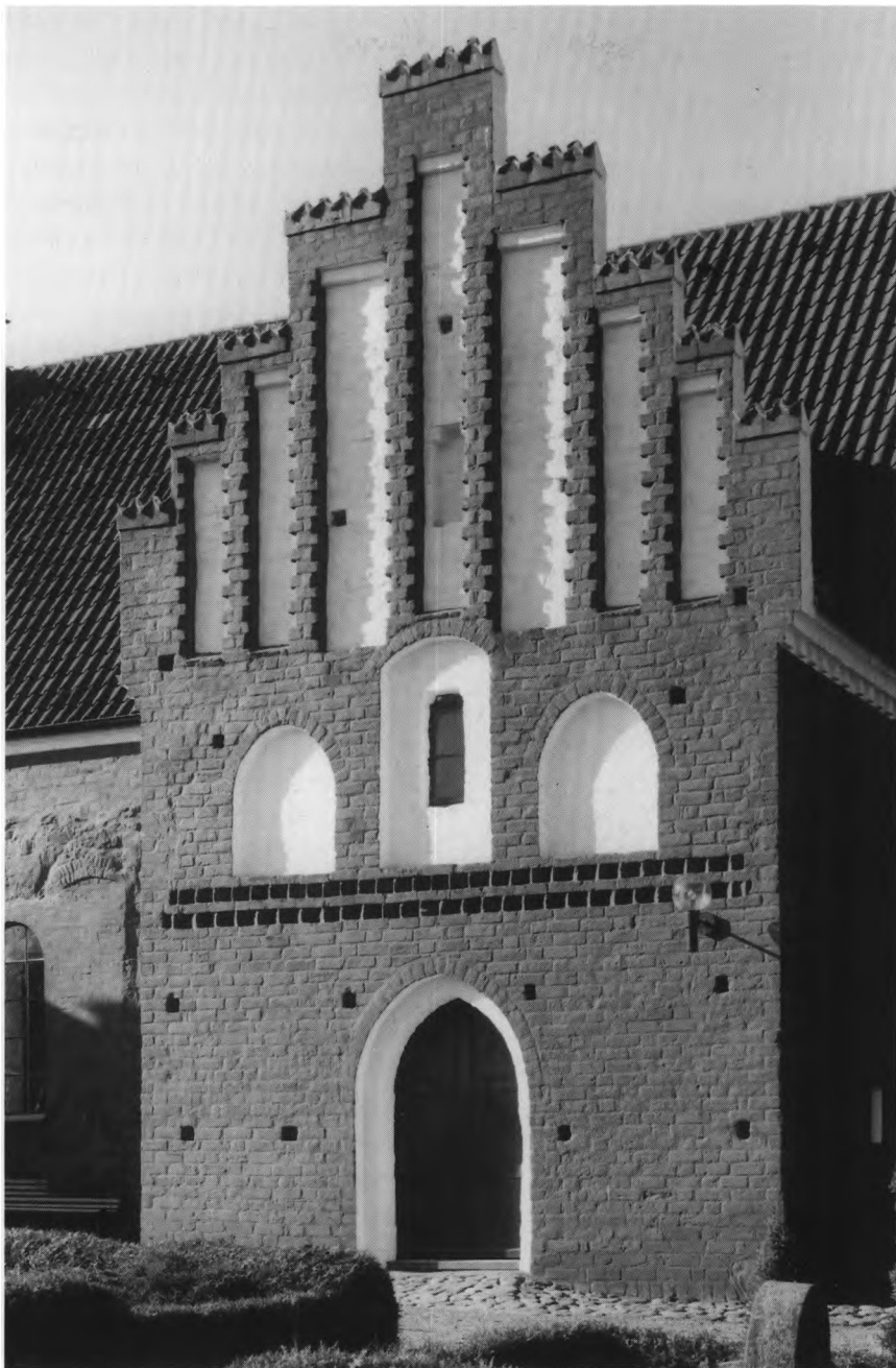
Fig. 8. Våbenhusets gavlvæg med oprindelige blændinger (s. 1720) under forhøjelsens kamtakkede blændingsgavl (s. 1726). HS fot. 1986. - Porch gable with original blind recesses below the heightened corbie-stepped gable.
