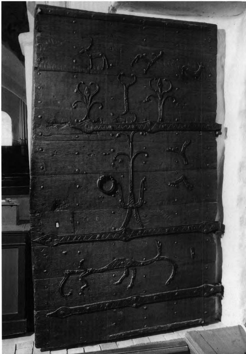
Fig. 58. Dørfloj nr. 1, middelalderlig, mellem våbenhus og skib (s. 1758). EM fot. 1966. - Door no. 1, medieval, between the porch and the nave.
