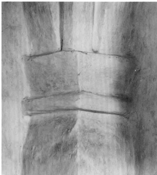
Fig. 68. Kragbånd på korhælvets nordøstre hjørnepille (s. 1723). EM fot. 1966. - Abacus on the north-east corner pillar of the chancel vault.
