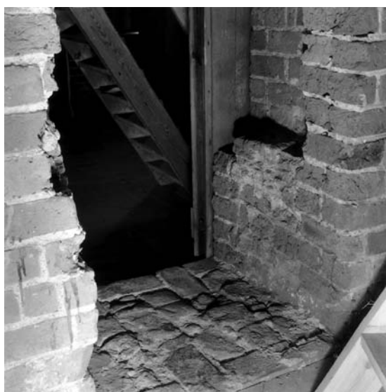
Fig. 14. Oprindeligt glamhul i tårnets klokkestokværk med sekundær forlængelse nedad (s. 1926). Set fra skibets loftsrum. Foto HJ 1998. – Original soundhole in the tower's belfry, with a secondary downward reaching extension. Seen from the nave loft.
